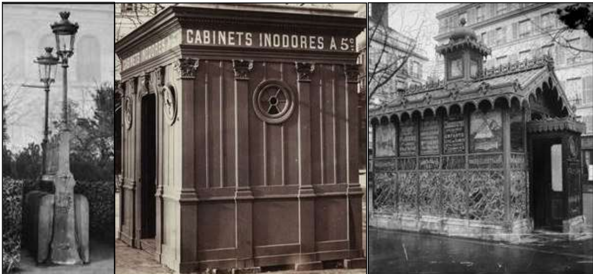
Figure 49 - vespasienne et cabinets inodores à Paris (1871)
