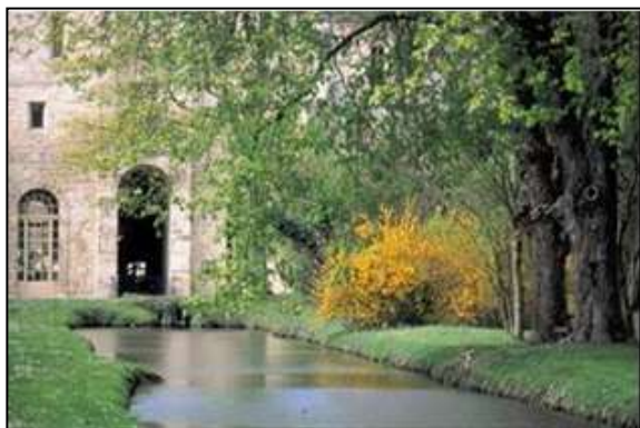
latrines reliées à l'étang Abbaye de Royaumont (XVIe s.)
