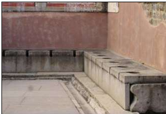
Figure 42 - latrines du musée de St Romain en Gal
