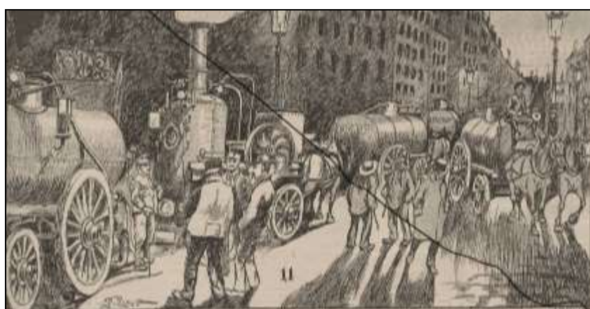
Figure 102 - vidange par une pompe à vapeur, UMDP (1890) 467
