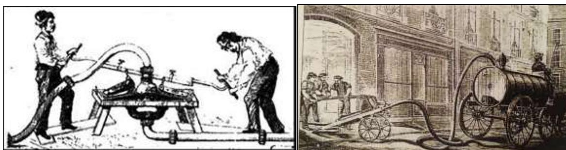
Figure 97 - pompe à soufflets pour la vidange des fosses fixes (1820)
