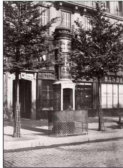
urinoir lumineux à une stalle avec écran, maçonnerie et vitrerie (Cie Delastre)
