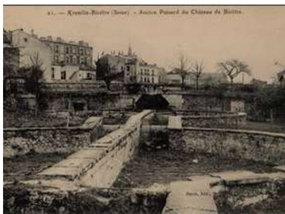
Figure 33 - puisard, Hôpital de Bicêtre (1850)
