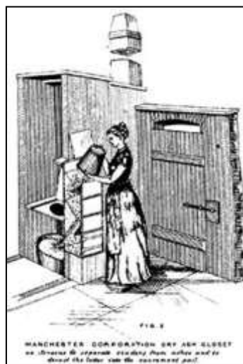
Figure 135 - latrine avec désinfection par la cendre 684 (1884)
