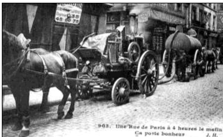
Figure 103 - équipage complet de vidange des fosses fixes (fin XIXe s.)
