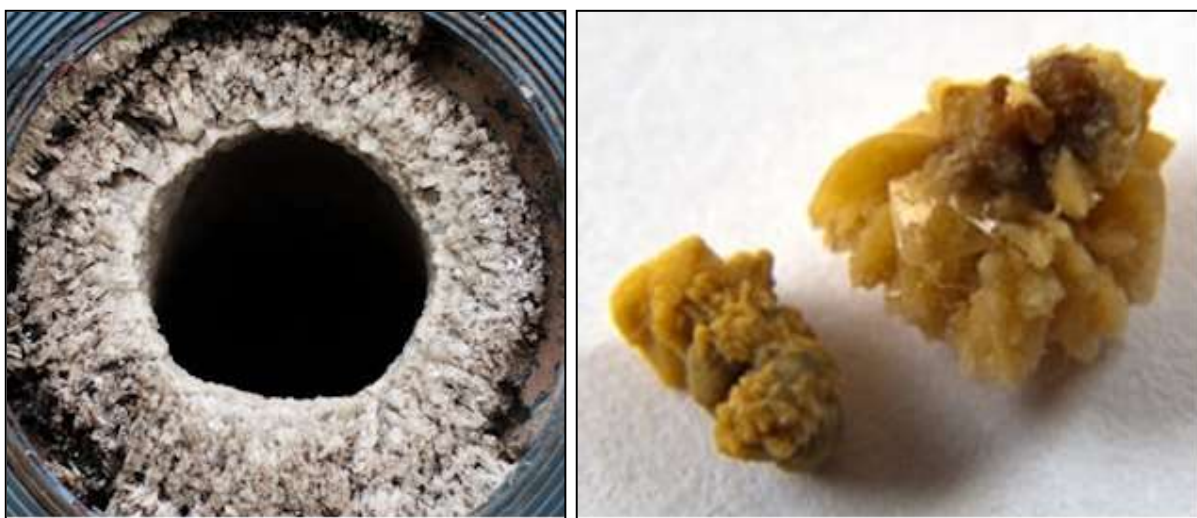
dépôt de struvite dans une canalisation
