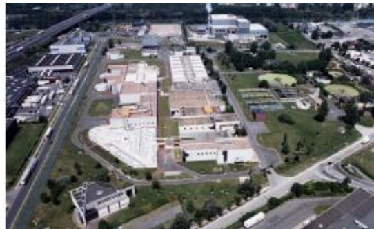
Biofiltration (Saint-Thibault-des-Vignes, 350 000 PE)
