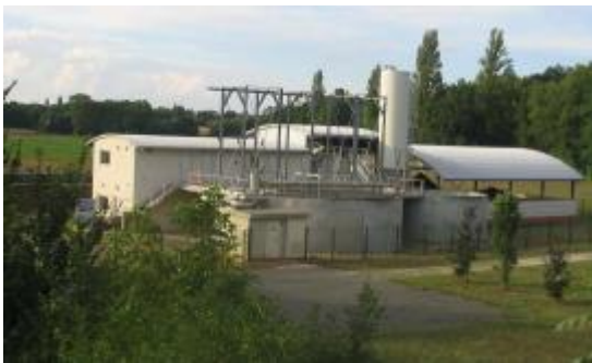
Membrane filtration (Perthes-en-Gâtinais, 4500 PE)
