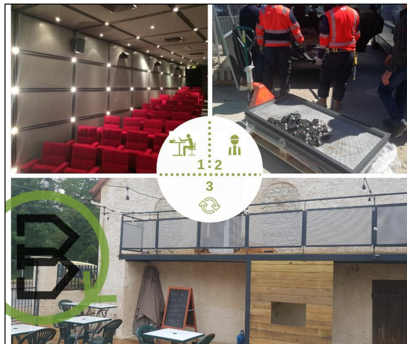
FIGURE 4.3 : TOLES PERFOREES MURALES D'UNE SALLE DE CONFERENCE REUTILISEES ET TRANSFORMEES EN GARDES-CORPS EXTERIEURS – SOURCE : BACKACIA
