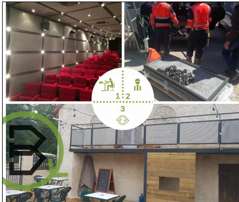
FIGURE 4.3 : TOLES PERFORÉES MURALES D’UNE SALLE DE CONFERENCE REUTILISÉES ET TRANSFORMÉES EN GARDES-CORPS EXTERIEURS – SOURCE : BACKACIA
