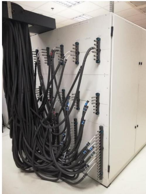
Figure 71 Système de gestion du fluide glycolé
