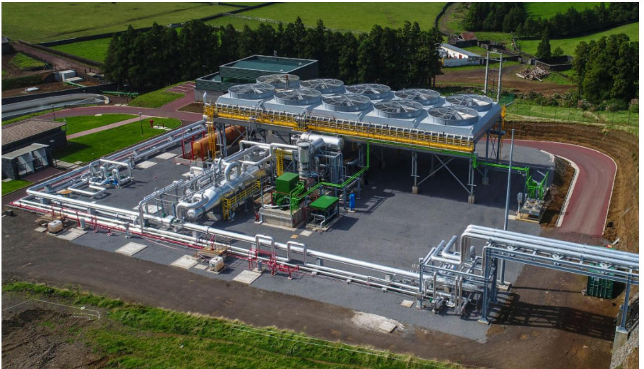
Figure 6.3: Exemple d'application employant un cycle non régénératif à un niveau de pression [3]
