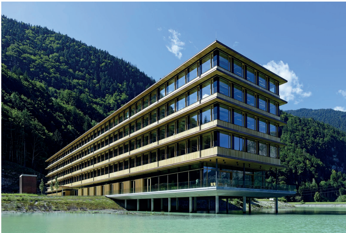
Figure I. 23 : Photo. IZM - Illwerke Zentrum Montafon, Vandans, Montage [9]
