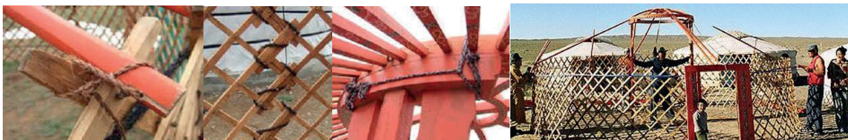
Figure I. 8 : Assemblages traditionnels des yourtes.
