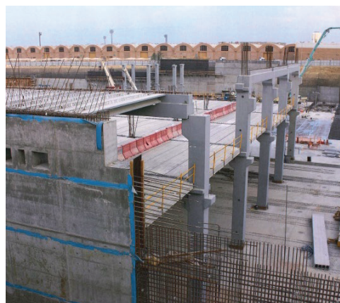
Figure I. 20 : Pose de la dalle préfabriquée du Métro de Ryad
