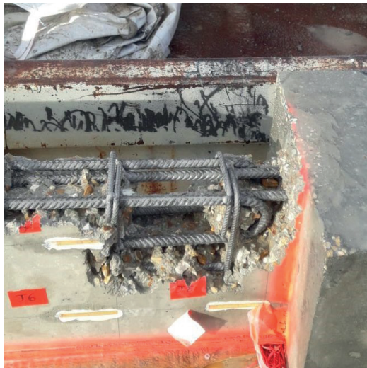
Assemblage en cours d'hydrodémolition
