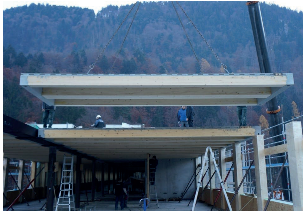
Figure I. 22 : Chantier. IZM - Illwerke Zentrum Montafon, Vandans, Montage [9]
