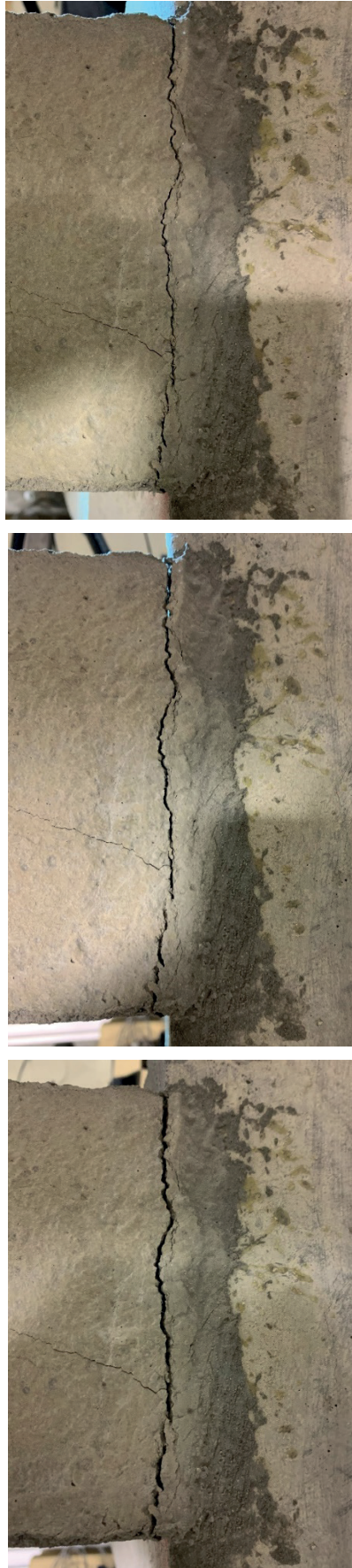
Figure IV. 53 : Ouverture progressive de la fissure au niveau de la jonction clavetage-poteau, lors du chargement à la rupture.
