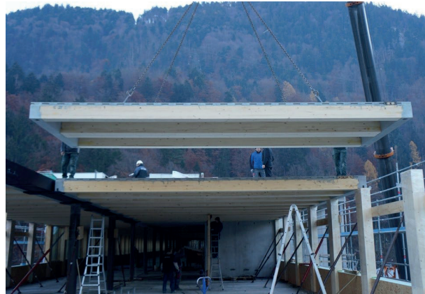
Figure I. 22 : Chantier. IZM - Illwerke Zentrum Montafon, Vandans, Montage [9]
