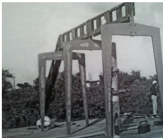
Figure I. 24 : Montage de la Maison tropicale Niamey [30]
