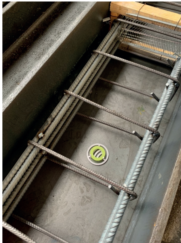
Figure IV. 12 : Puce RFID préparée en fond de coffrage avant le coulage du béton.
