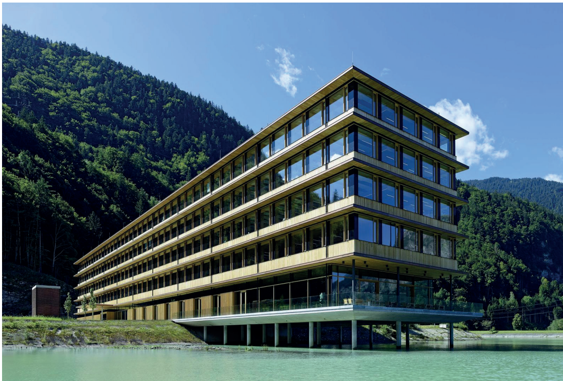
Figure I. 23 : Photo. IZM - Illwerke Zentrum Montafon, Vandans, Montage [9]
