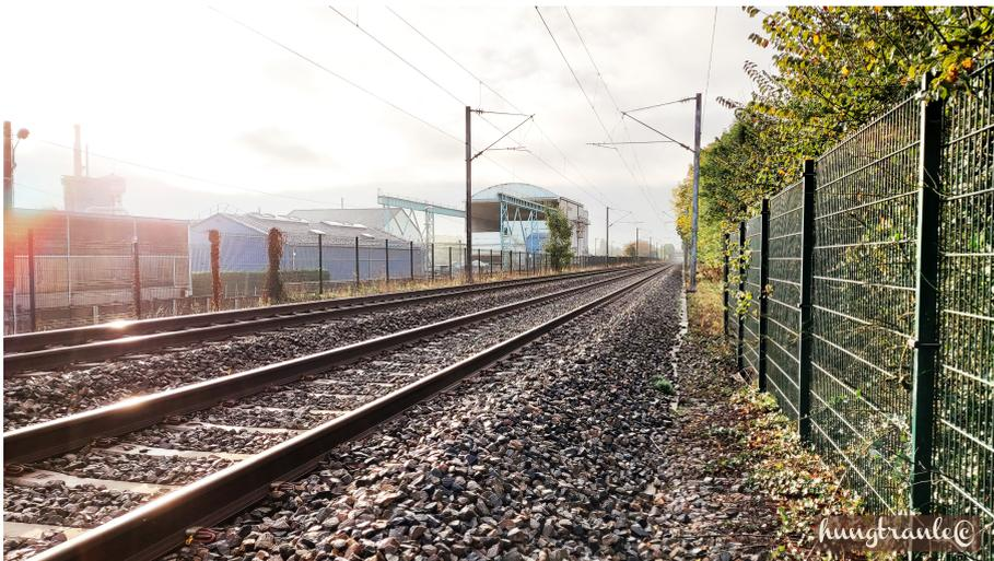
FIGURE 1.1 – Voie ferrée ballastée (photo source : *hungtranle* ©)
