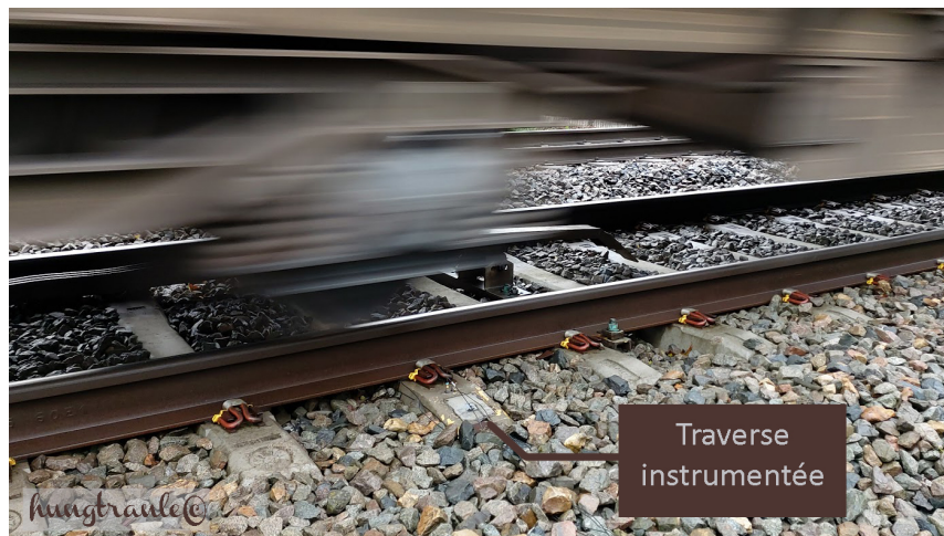
FIGURE 5.18 – Mesure sur site avec un passage de train (photo source : hungtranle ©)
