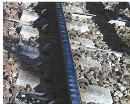
Figure 27 : Usure ondulatoire du rail (Mai, 2011)
