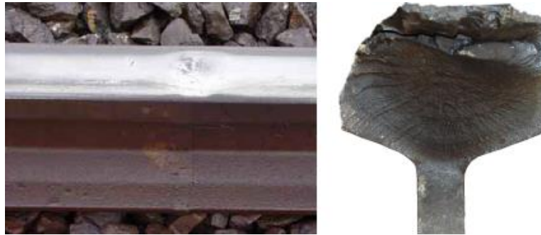
Figure 25 : Cas de fissuration par fatigue en configuration dite « squat » vue de dessus et en coupe (Trollé, 2014)
