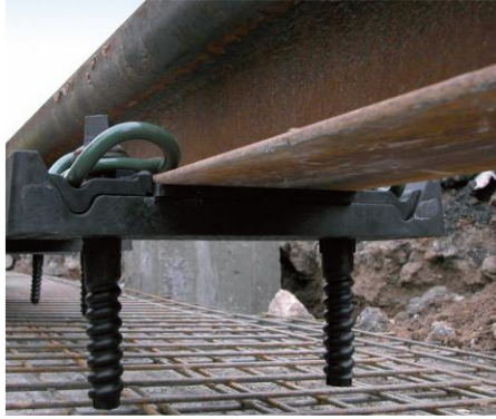
Figure 9 : Exemple de pose sur selles avant scellement (Source : ARTELIA Ville & Transport)
