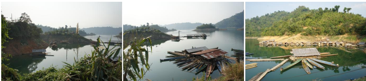
Figure 1.5 : Photographies du réservoir prises au mois de mars, depuis la fin de la route y menant, en regardant vers l'ouest, vers le nord et vers l'est. La limite boisée des versants correspond au niveau maximal de l'eau, atteint au mois de septembre.
