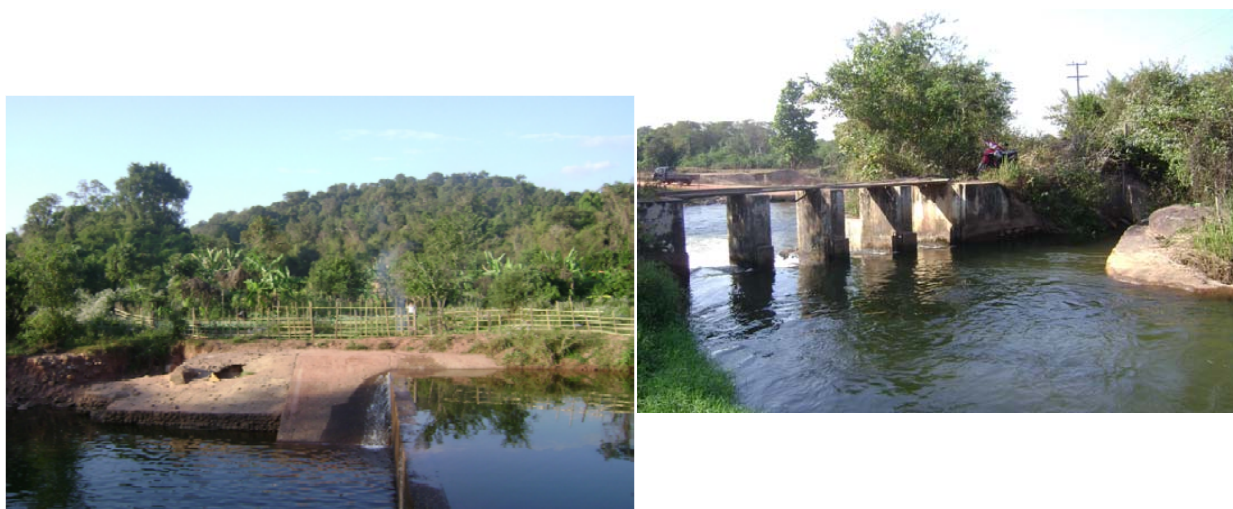
Photo 38 : Barrage de dérivation en béton sur la Nam Nyam (À ban Namnyam, décembre 2010)
