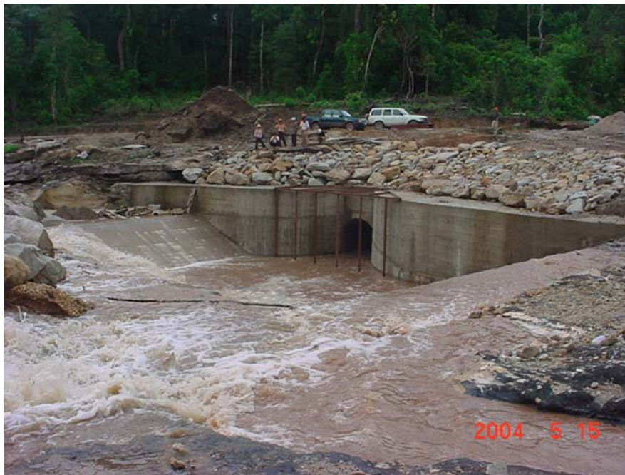
Photo 76 : Digue pour dériver l'eau du Houay Khouang au réservoir de Nam Mang 3 Source : Électricité du Laos, mai 2004
