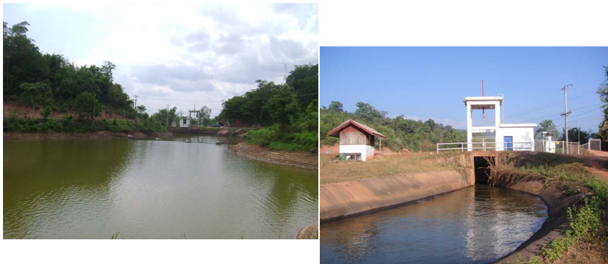
Photo 79 : Vanne entre le bassin de régulation et le canal d'irrigation en béton (À ban Namnyam, décembre 2011)
