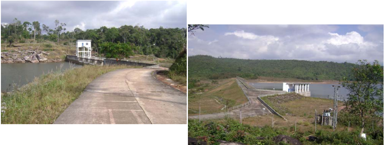
Photo 75 : Digue en terre compressée (ou barrage secondaire) d'une hauteur de 19 m (Plateau de Phou Khao Khouay, février 2011)
