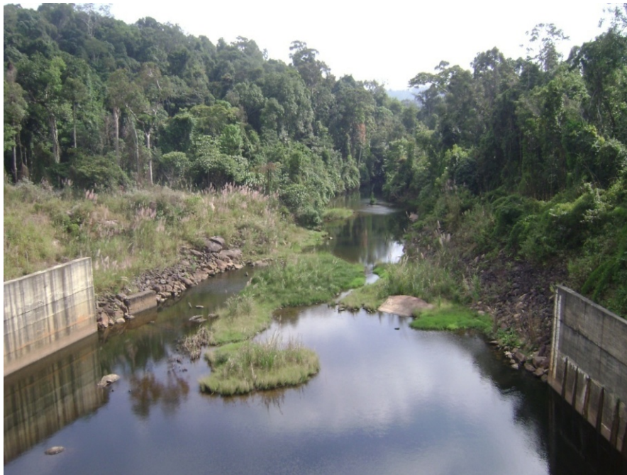
Photo 87 : Arrière du barrage situé sur la Nam Nyong (À Phou Khao Khouay, février 2011)
