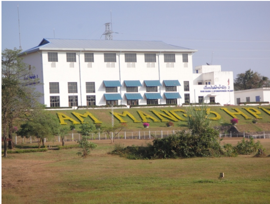
Photo 77 : Centrale électrique du barrage hydroélectrique de Nam Mang 3 (À ban Nam Nyam, janvier 2012)
