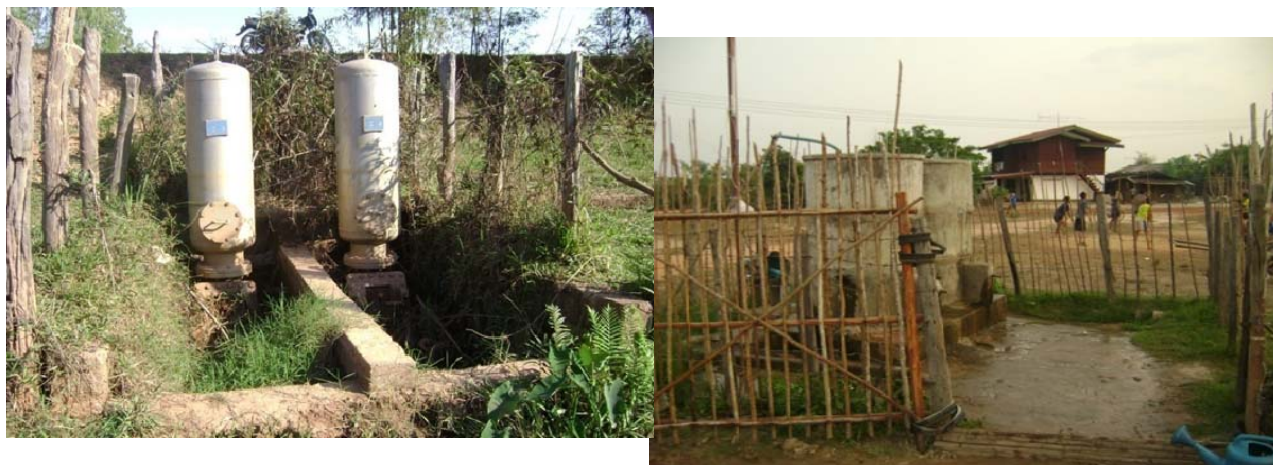
Photo 90 : Deux puits de forage au village PKKy-mai financés par le projet du barrage hydroélectrique de Nam Mang 3 (À ban Phoukhaokhouay, avril 2009)
