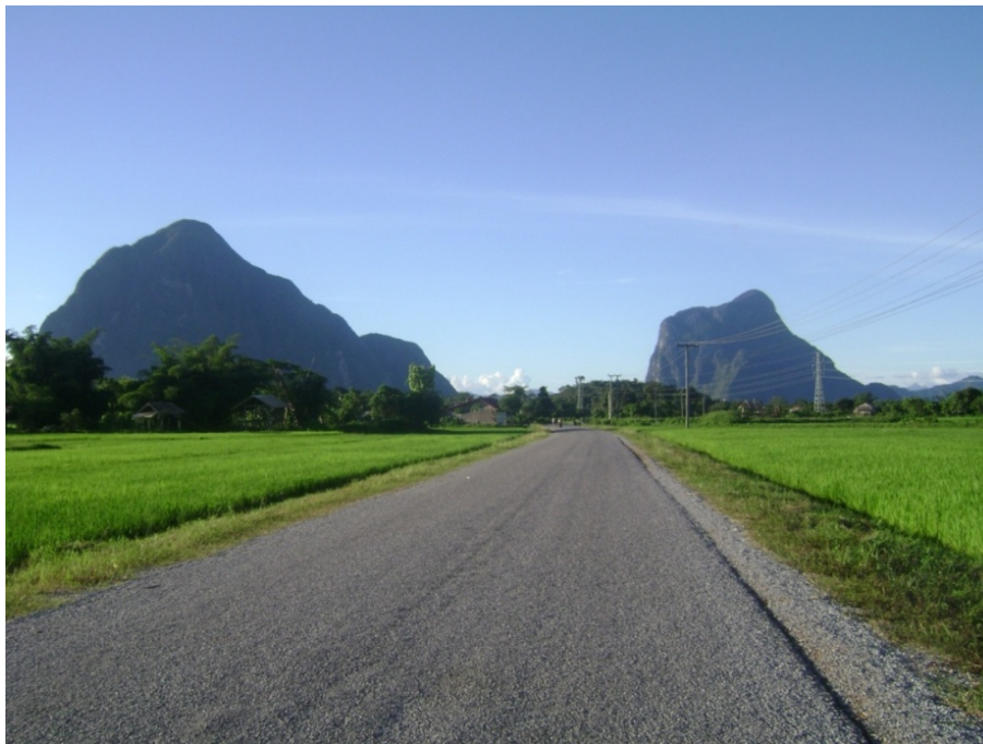
Photo 84 : Route construite grâce au projet du barrage hydroélectrique de Nam Lik 1-2 (À ban Meuangfeuang, août 2010)
