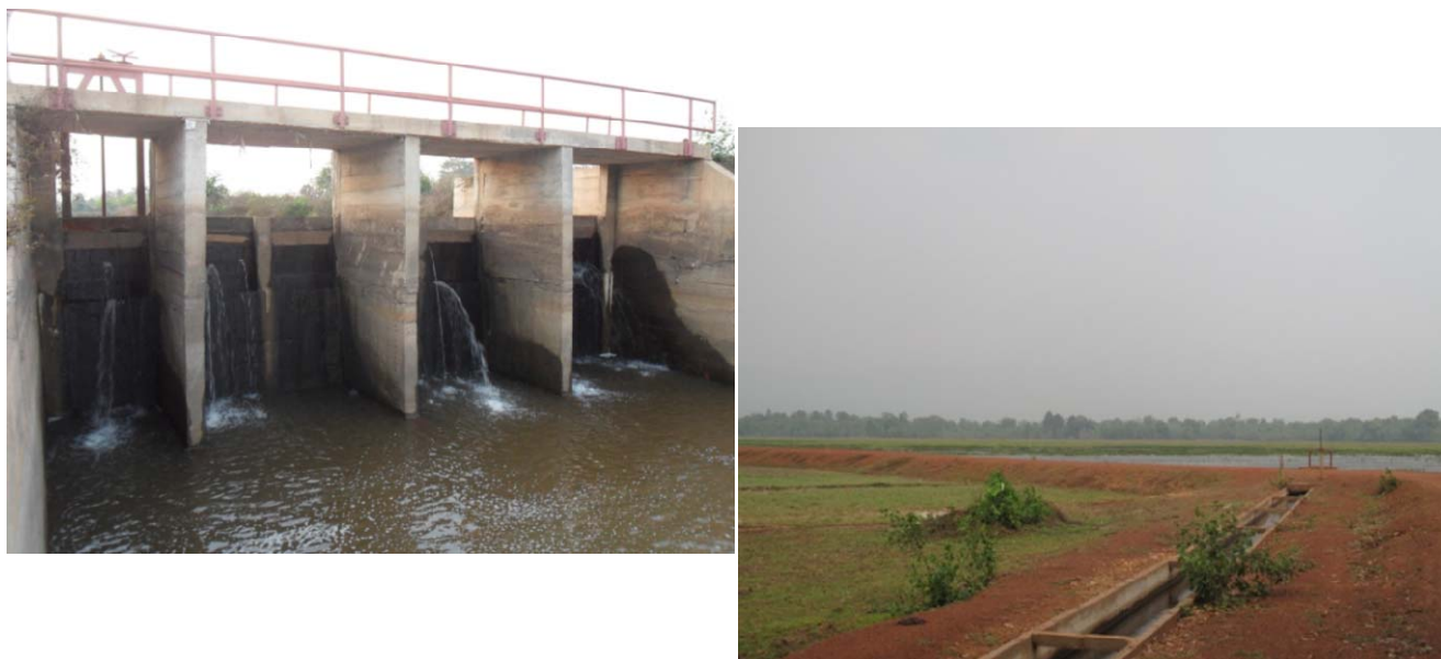
Photo 43 : La digue retenant l'eau de l'étang de Sa ngan et le canal d'irrigation en béton (À ban Nakèo, février 2011)
