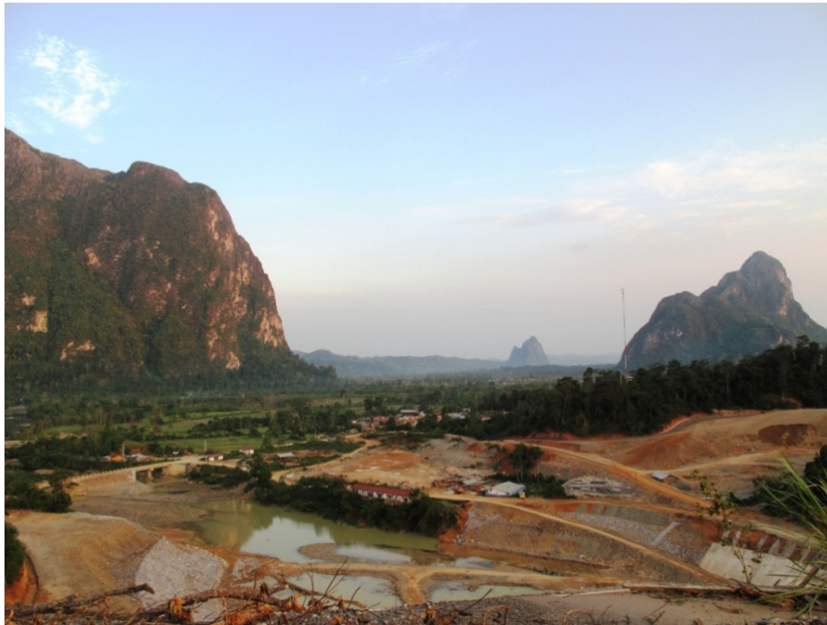
Photo 85 : La zone de construction, située juste derrière le barrage
