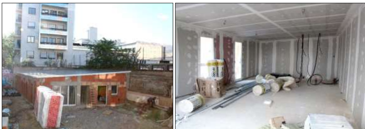
La salle commune : vue depuis l'immeuble (photo 1) et vue de l'intérieur (photo 2)
