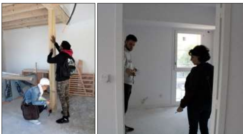
Deux familles en train prendre les mesures des espaces de leur appartement Visite de chantier du 29-05-19
