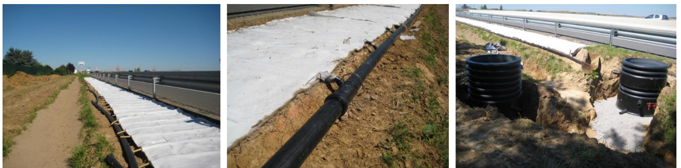
Figure 2.7. Récupération du débit d'infiltration dans la bande enherbée.
