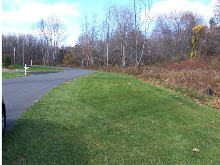
Figure 1.1. Bande enherbée en bordure de voirie. (Source: Trinkhaus Engineering)
