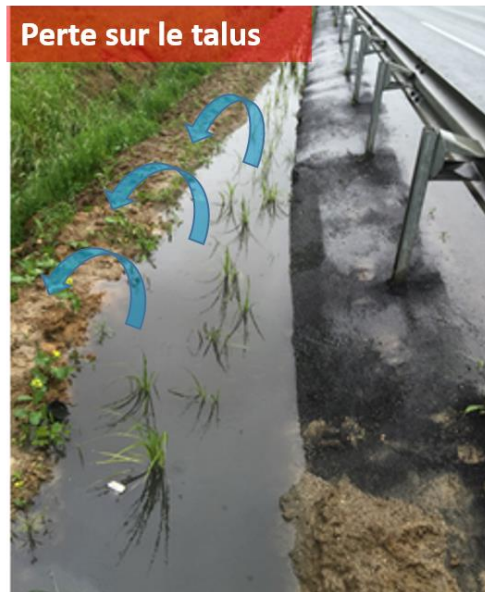
Figure 3.53. Photo de la noue filtrante montrant une possibilité de perte d'eau sur le talus.
