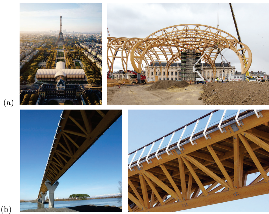
Figure 3-3 Exemples de structures treillis en bois
