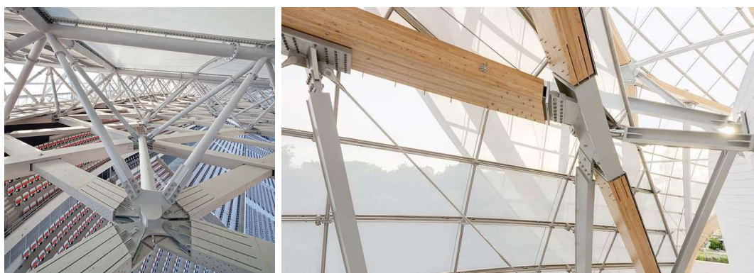
Figure 1-1 Assemblages par broches du stade de l'Allianz Riviera à Nice construit en 2013 et de la Fondation Louis Vuitton à Paris construit en 2014 Crédits : elioth ; Rensteph Thompson, HESS TIMBER
