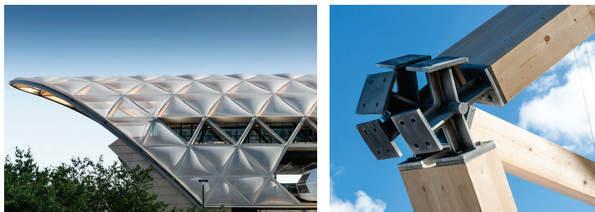
Figure 3-35 Structure en bois de la couverture de la station Canary Wharf à Londres construite en 2014. Crédits : seele.com
