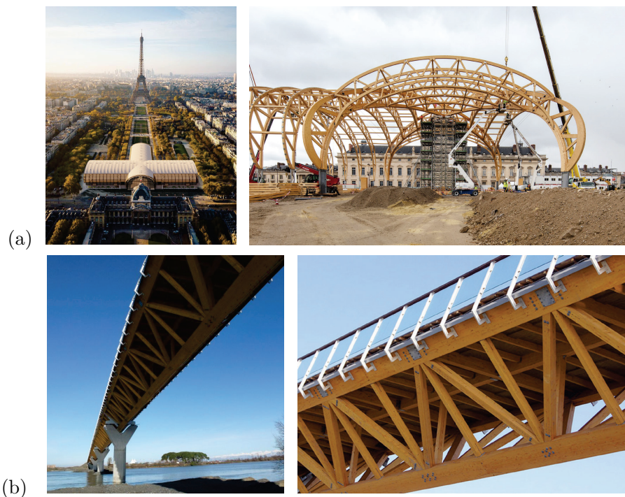
Figure 3-3 Exemples de structures treillis en bois
