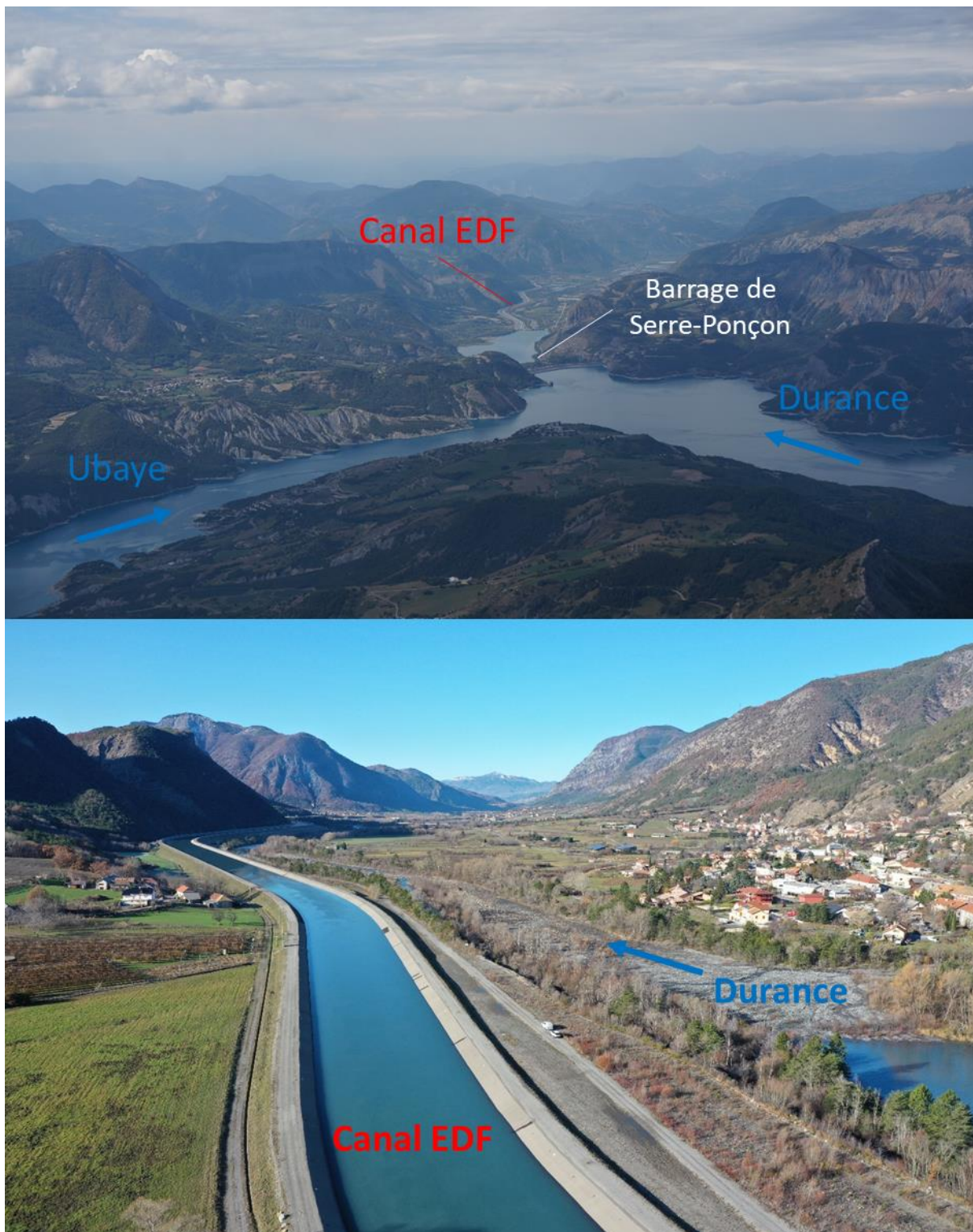
Figure 2 : Barrage de Serre Ponçon à la confluence de l'Ubaye et de la Durance (haut) et canal EDF qui longe la Durance (bas). Source : M. Laurenceau.
