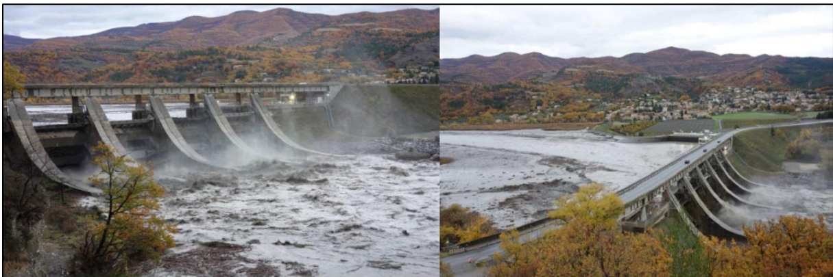
Figure 70 : Photos pendant la mise en transparence du barrage de l'Escale, en novembre 2016. Source : EDF, 2016.
