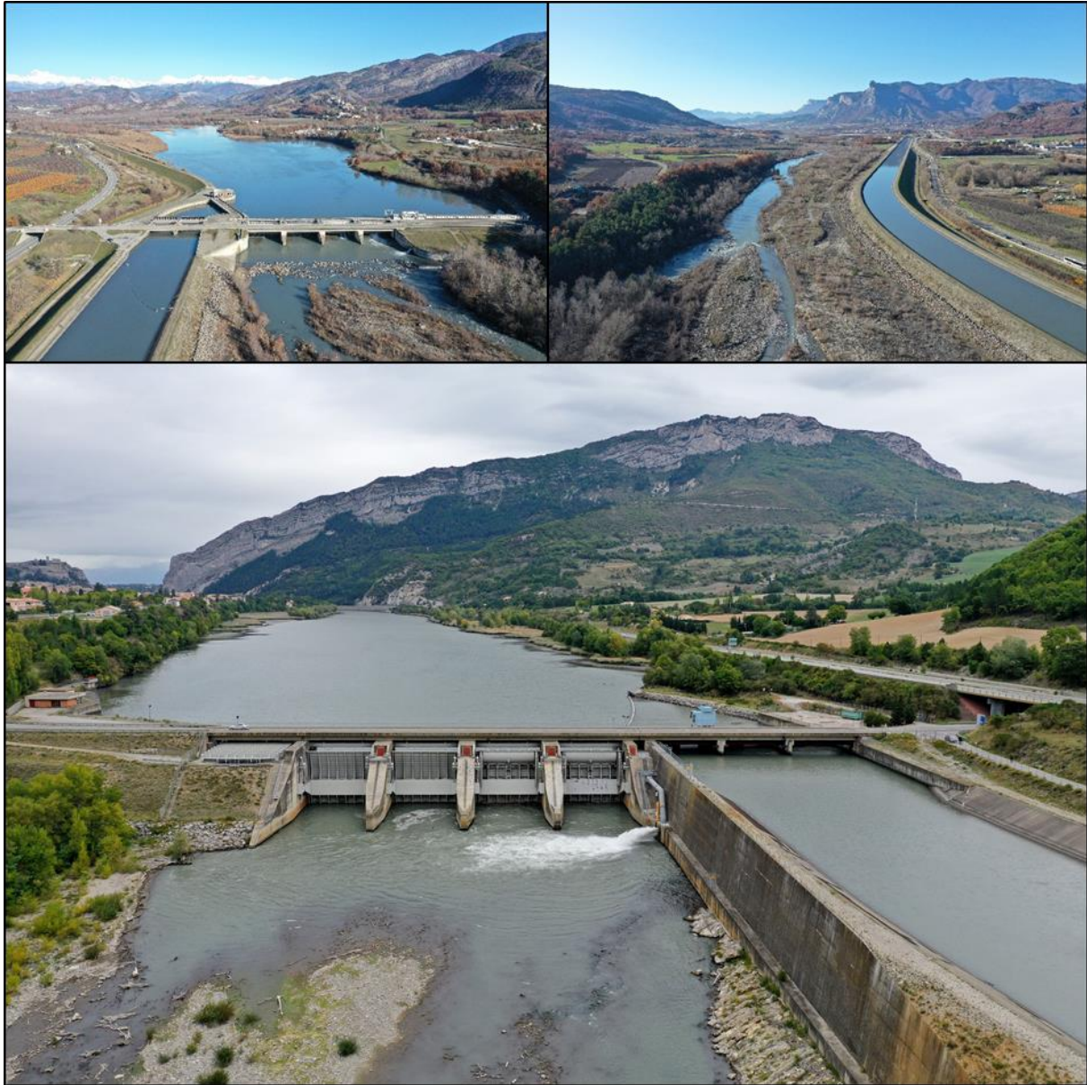
Figure 36 : Barrage de la Saulce (en haut à gauche vers l'amont, en haut à droite vers l'aval) et de Saint-Lazare (en bas). Source : Laurenceau, 2019.
