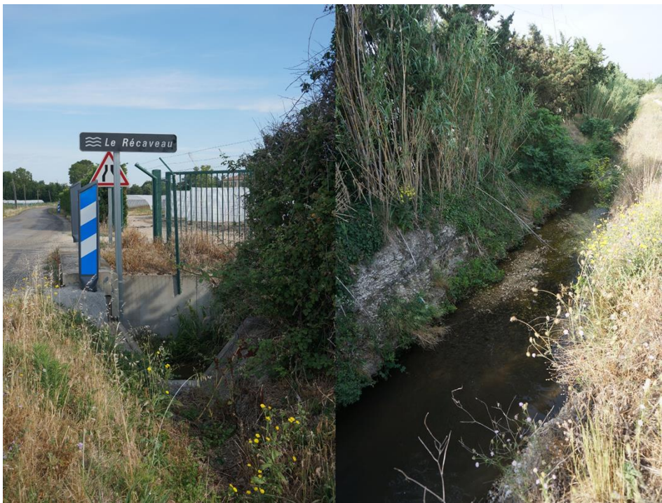
Figure 108 : Retour de canal vers le Récaveau. Source : auteur.
