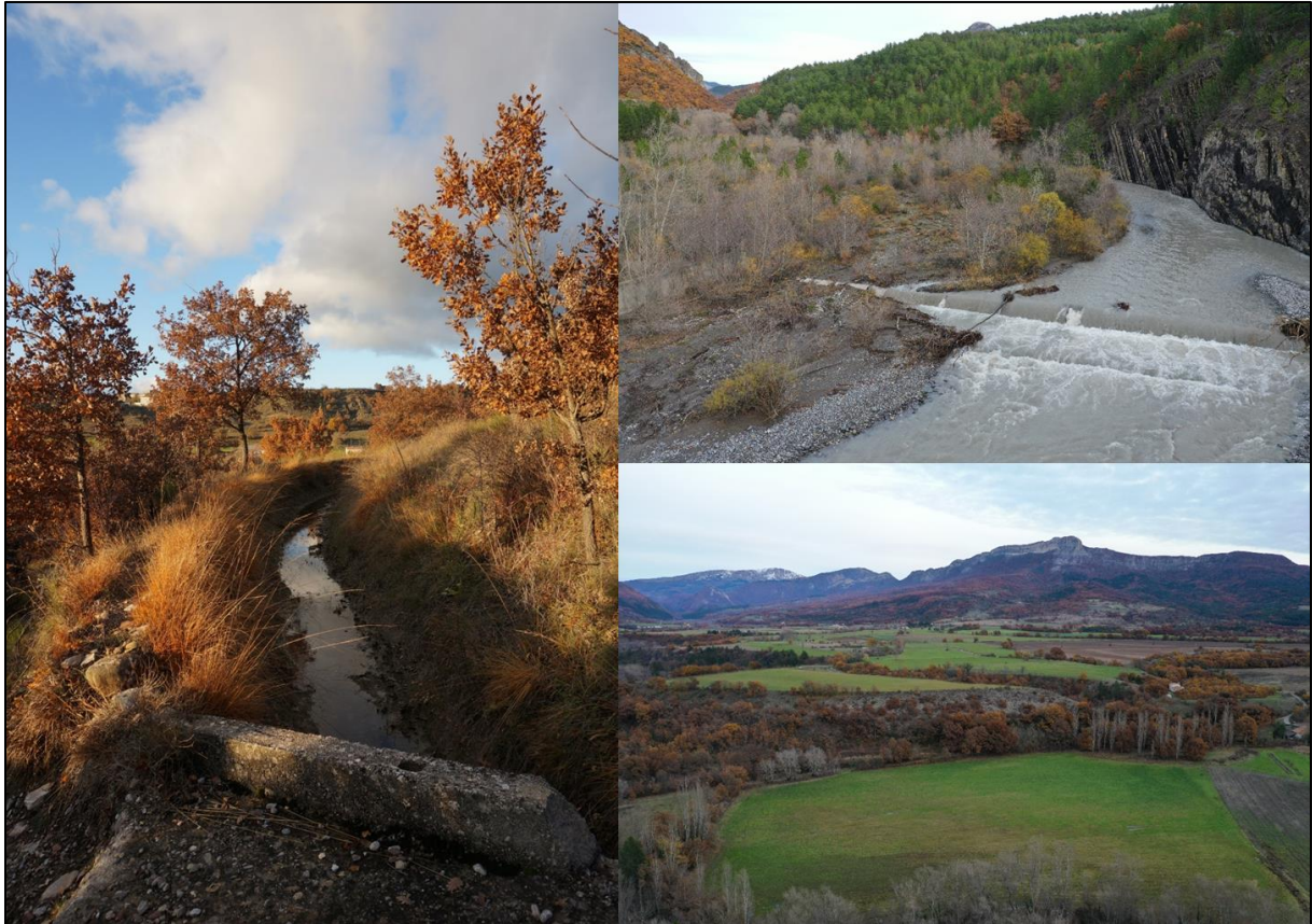
Figure 72 : Canal gravitaire de Saint-Tropez (à gauche). Prise du canal (en haut à droite) et plaine agricole irriguée sur le secteur de Valernes (en bas à droite). Source : auteur, 2019.
