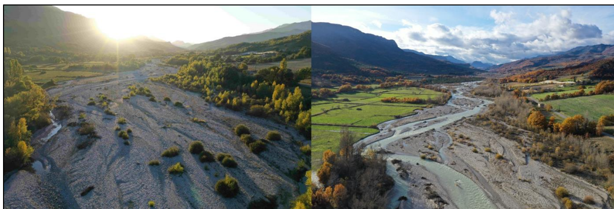
Figure 74 : Jabron vu depuis le pont de Valbelle, en octobre (situation d'étiage) et décembre 2019. Source : M. Grau, 2019
