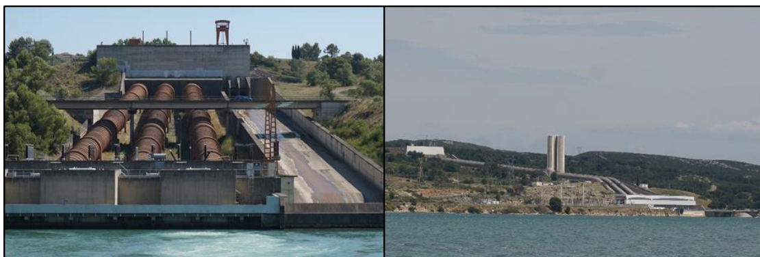
Figure 32 : Centrales hydroélectriques de Mallemort (gauche) et de Saint-Chamas (droite). Source : auteur.
