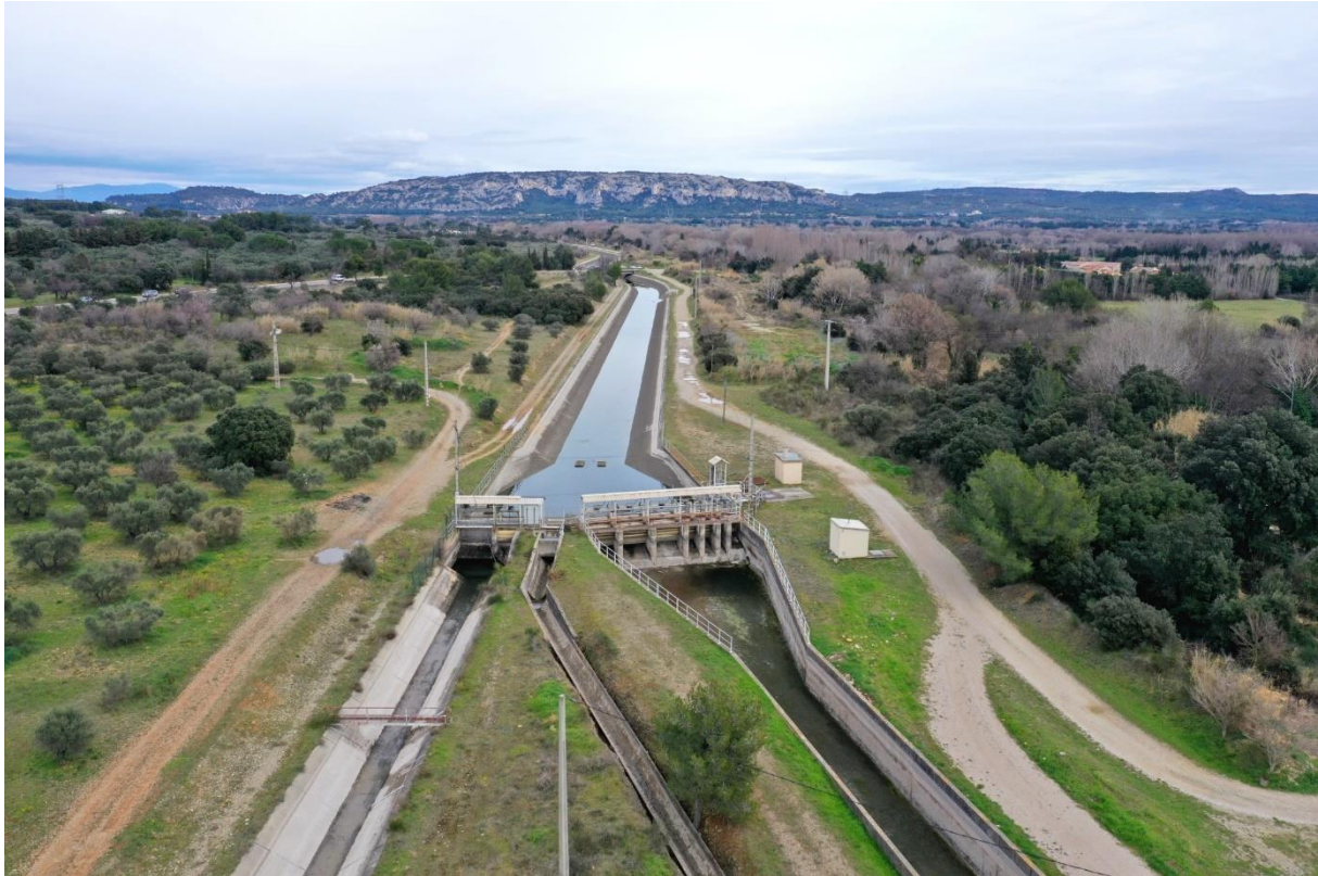
Figure 34 : La majorité des prises agricoles sont connectées au canal EDF. Dans cette photo, on voit les trois canaux principaux de la Crau et leur alimentation depuis le prolongement du canal EDF (Canal de Boisgeline Crau co-géré par les ASAs et EDF). Source : auteur.
