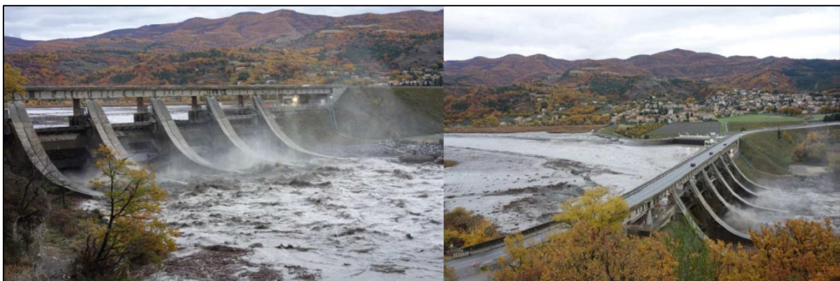
Figure 70 : Photos pendant la mise en transparence du barrage de l'Escale, en novembre 2016. Source : EDF, 2016.
