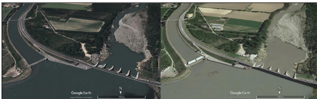
Figure 69 : Barrage de l'Escale, avant l'installation de la vanne de fermeture (mai 2011) et après (août 2018). Source : auteur à partir de Google Earth.
