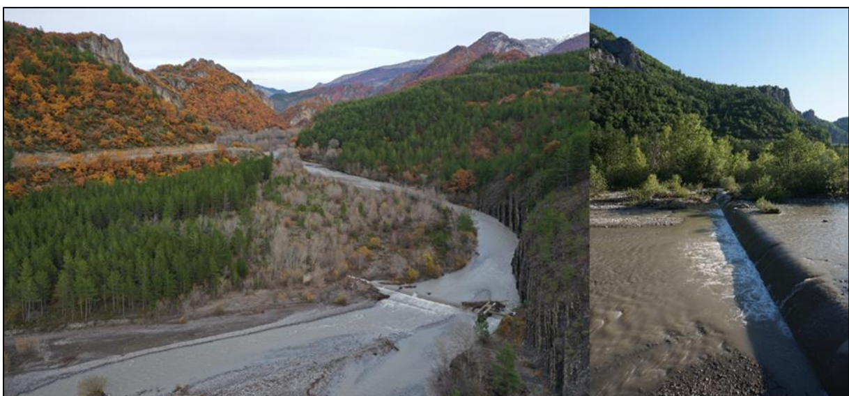
Figure 150 : Prise d'eau du canal de Saint-Tropez en novembre (gauche) et juillet (droite) 2019. Source : auteur.
