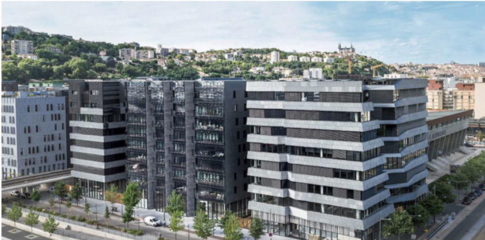
Figure 1. 9. Photo de l'îlot Hikari. Source : https://www.ecologikmagazine.fr/energie-vitale-a1169
