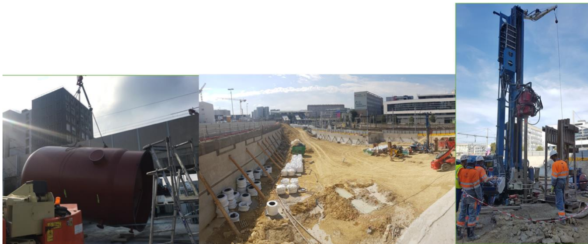
Figure 3. 19. Photos du début du chantier en 2016. De gauche à droite : les cuves de Colza, la préparation du terrain pour le champ de sondes et un appareil de forage des sondes. Sources : photos prises par UrbanEra.
