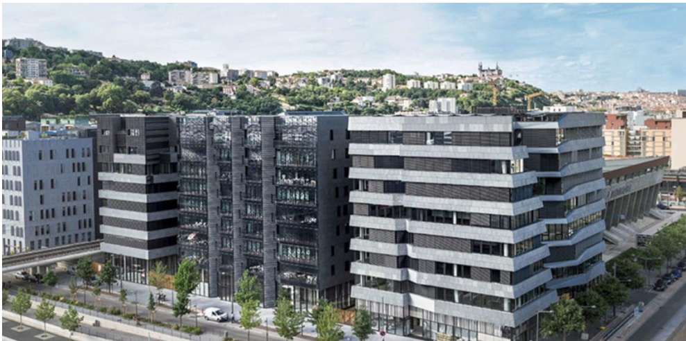
Figure 1. 9. Photo de l'îlot Hikari. Source : https://www.ecologikmagazine.fr/energie-vitale-a1169
