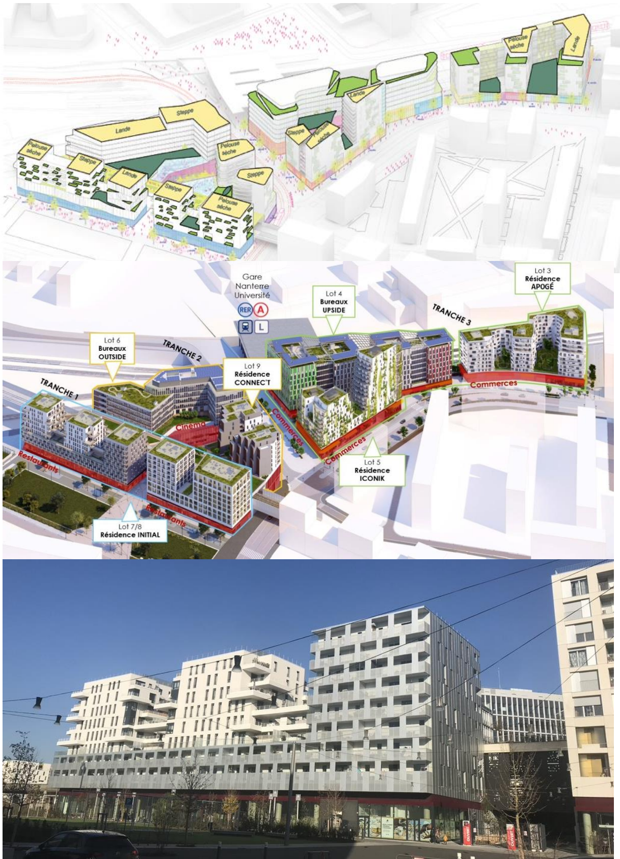
Figure 3. 16. De haut en bas : axonométrie de principe d'implantation des différents espaces verts réalisée en 2015 (Source : Bouygues Immobilier) ; Visualisation tridimensionnelle finale du projet à Nanterre (Source : Bouygues Immobilier) ; Photo de la tranche 1 du comportant plusieurs commerces au RDC (Prise par l'auteur).
