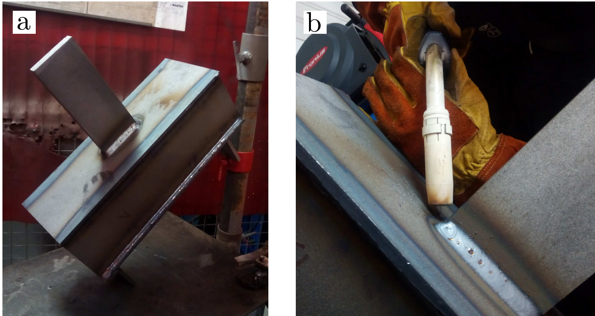
FIGURE II.19: Soudage du bouclage au niveau du gousset supérieur sur la structure complexe ; a : position de la structure avant soudage ; b : position de soudage utilisée (PA, soudage manuel).
