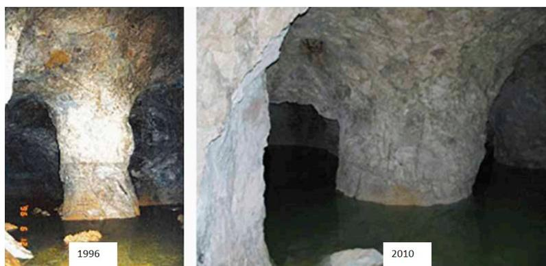
Figure 5.5 – Vues d'un même pilier dans la carrière abandonnée de Roquevaire (Bouches-du-Rhône- 13) avec deux niveaux d'ennoyage différent (en 1996 et en 2010) ©Ineris
