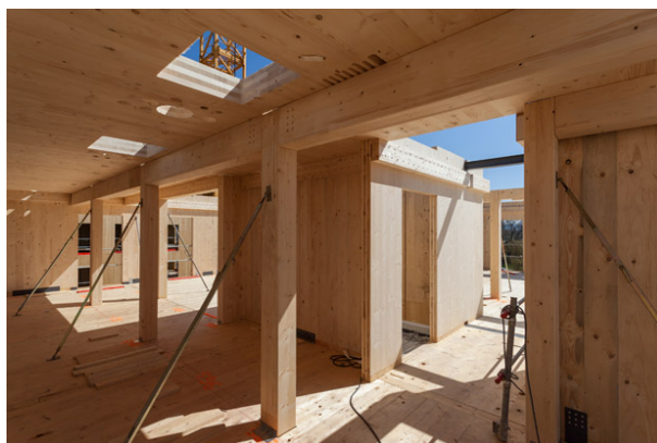
FIGURE 0.1 – Construction de la tour Sensation îlot bois Strasbourg crédit photo : Bouygues Immobilier
