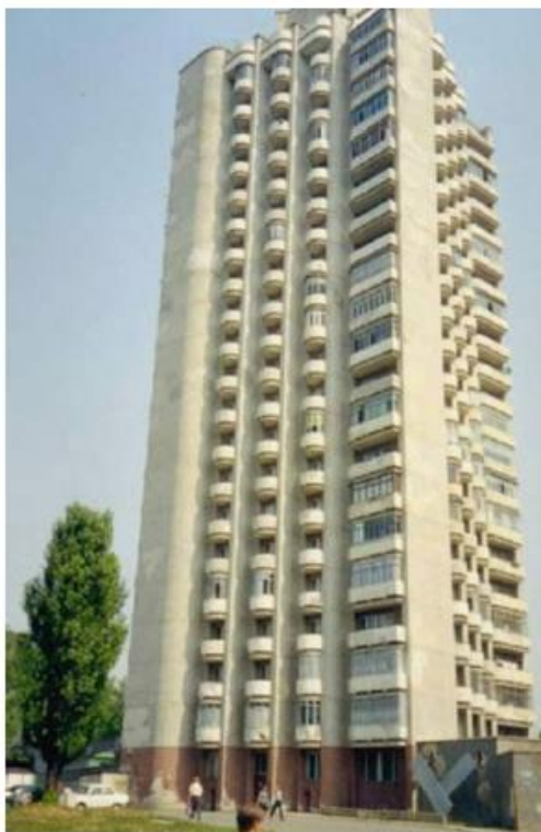
Figure 27. Première structure en béton géopolymère a été construite en 1994 à Lipetsk, en Russie, [84].
