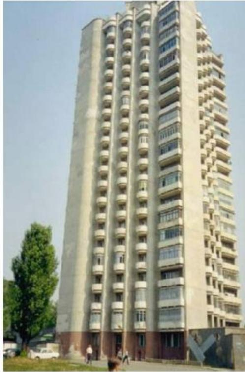
**Figure 27.** Première structure en béton géopolymère a été construite en 1994 à Lipetsk, en Russie, [84].
