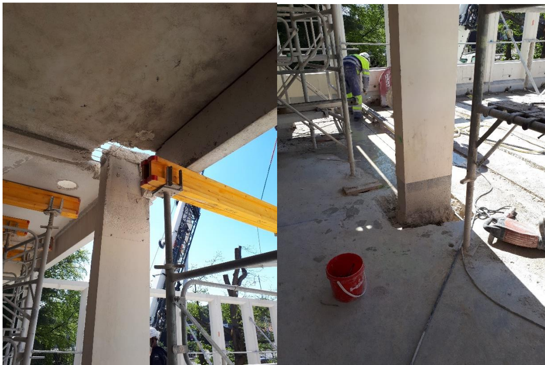
Figure 111 : Démontages des poteaux coulés sur place au chantier de Lyon
