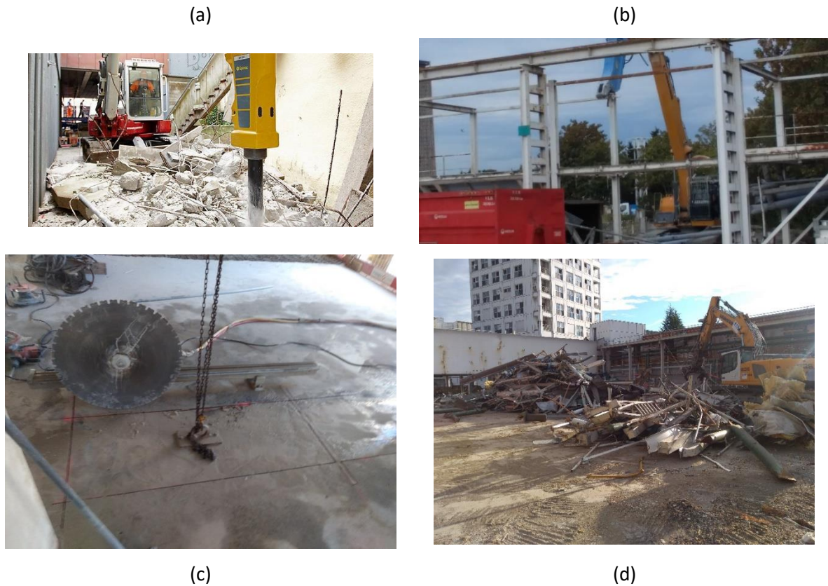
Figure 18 : (a) Démolition au Brise Roche Hydraulique (BRH) ( https://www.blanchard-tp.com consulté le 01/10/2021) ;(b) Méthode de coupe à la pince hydraulique d'éléments en acier (photo : Ambroise LACHAT) ; (c) Méthode par découpage d'une poutre à la scie diamantée (photo : Ambroise LACHAT) ; (d) Tri des éléments acier après découpe (photo : Ambroise LACHAT)
