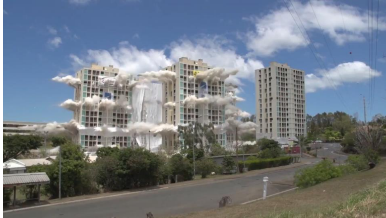
Figure 19 : Tours démolies par foudroyage, Saint Quentin, Ginger Deleo ( https://www.ginger-deleo.com consulté le 01/10/2021)
