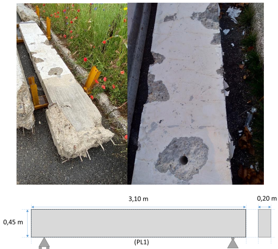
Figure 112 : Présentation du poteau « PL1 » (chantier de Lyon)
