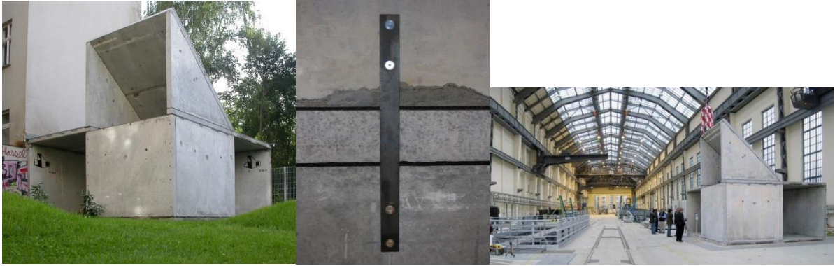
Figure 83 : Plattenpalast, architecte : Carsten Wiewiorra, 2009, Prototype de maison construite à partir de dalles et voiles préfabriqués issus de la déconstruction d'ancien HLM
