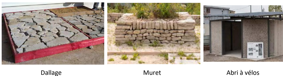
Figure 86 : Exemples de réalisation par l'association Bellastock à partir d'éléments en béton (Clos Saint Lazare - Stains)
