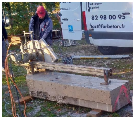
Figure 165 : Redécoupage des poutres à l'ENPC par l'entreprise Forbétou
