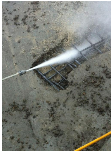
Figure 21 : Hydro démolition ( https://www.diamantex.ca , consulté le 01/10/2021)
