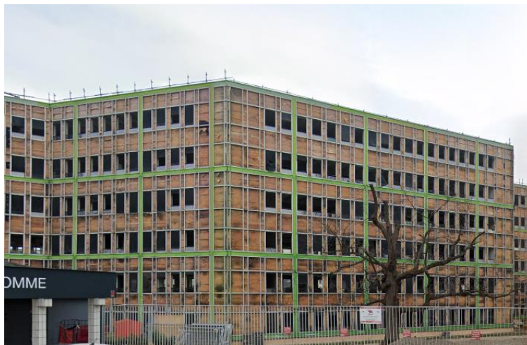
Figure 109 : Chantier de rénovation de bureaux à Champagne au Mont d'Or (69), appelé dans la suite de la thèse « chantier de Lyon » (Image google maps)
