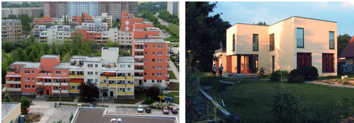
Figure 83 : Plattenpalast, architecte : Carsten Wiewiorra, 2009, Prototype de maison construite à partir de dalles et voiles préfabriqués issus de la déconstruction d'ancien HLM
