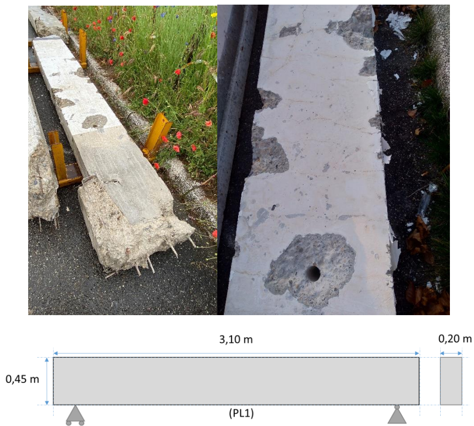
Figure 112 : Présentation du poteau « PL1 » (chantier de Lyon)
