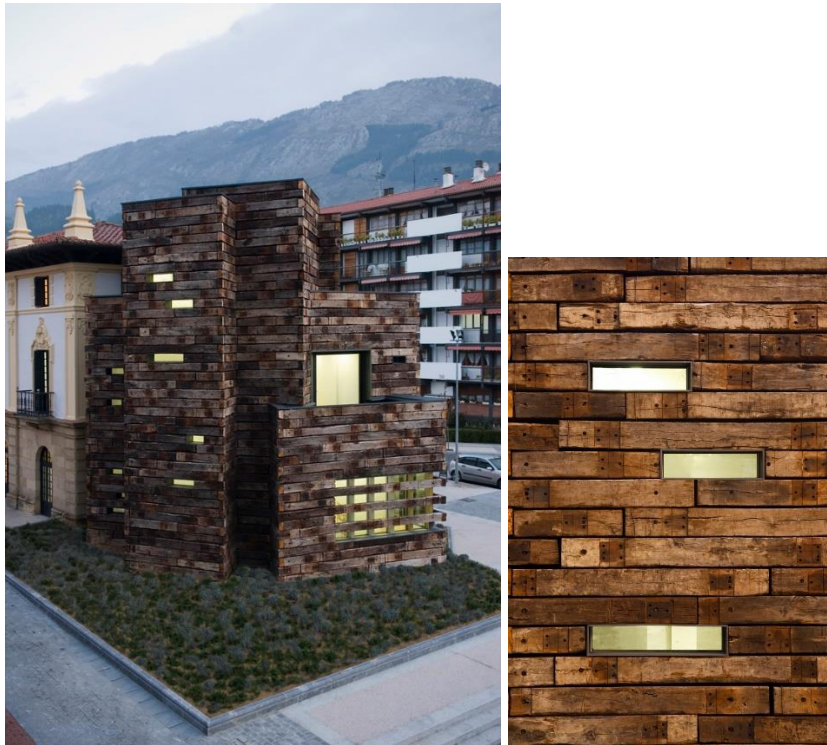
Figure 79 : Photographie de l'extension de la librairie Aizkibel (Espagne) par Estudio Beldarrain (photo Jon Cazenave). Réemploi des traverses de voies de chemin de fer en façade
