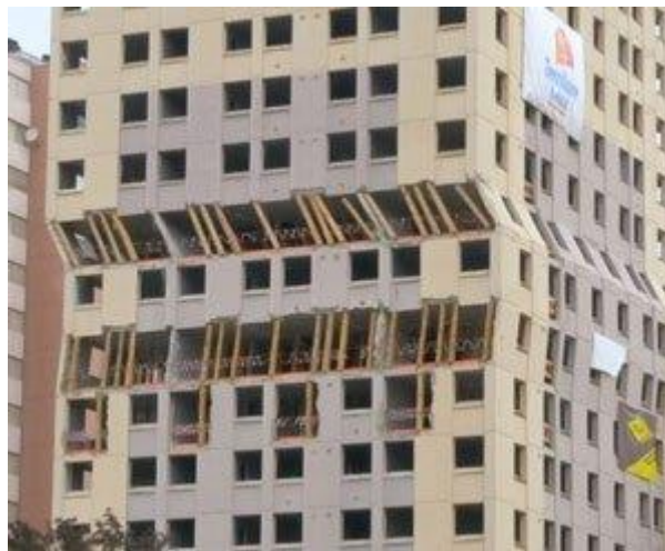
Figure 20 : Vérinage de deux tours (Premys-Ferrari démolition)
