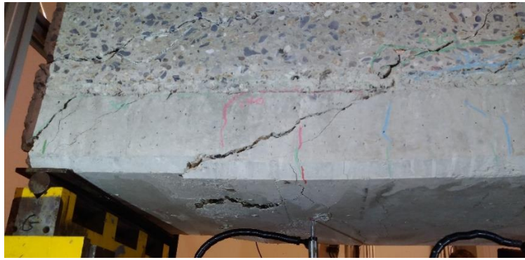
Figure 144 : Détail de la rupture sur la fibre inférieure (PuP2)
