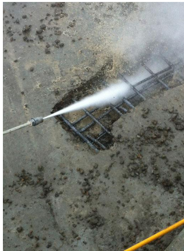
Figure 21 : Hydro démolition ( https://www.diamantex.ca , consulté le 01/10/2021)
