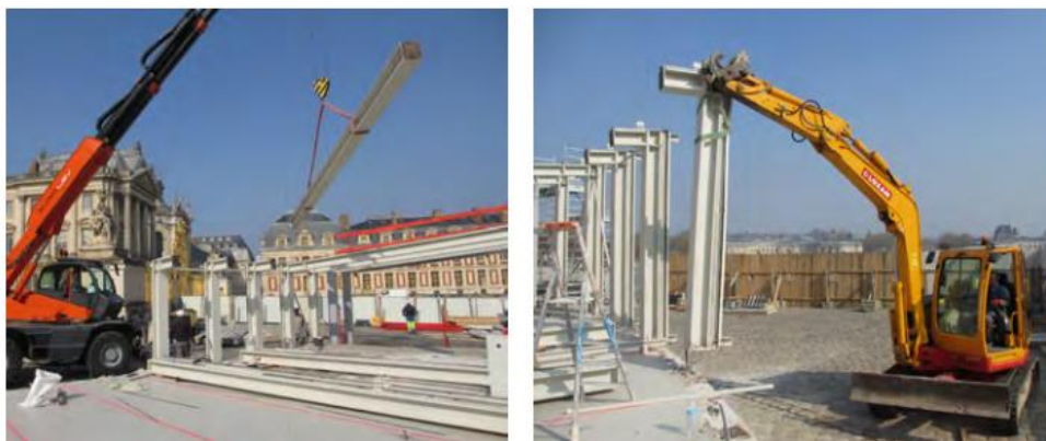
Figure 81 : Dépose par déboulonnage et élingage de la structure métallique du pavillon provisoire à Versailles (Benoit et al., 2018)
