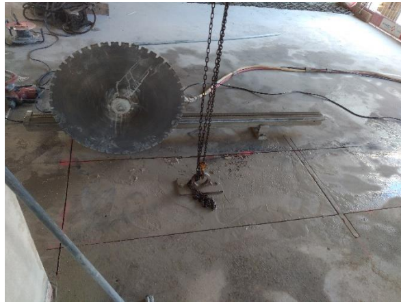
Figure 164 : Méthode de déconstruction de la poutre dans le cadre du chantier de Levallois Perret (92) appelé chantier de Paris
