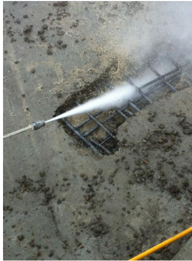
Figure 21 : Hydro démolition ( https://www.diamantex.ca , consulté le 01/10/2021)
