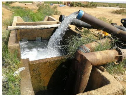
Figure 11 : Motopompes installées pour l'irrigation de casier rizicoles à Diadiam (Crédit Photo: C. Deniau, 2019)
