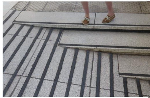
Figure 31 : volée de marches sur le bord d'une rampe en gare d'Issy Val de Seine
