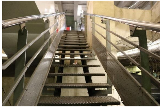
Figure 29 : escalier de la gare de Paris Montparnasse.
