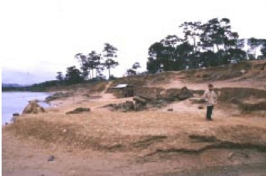
Figure 101 : l'érosion de la berge du tombeau de Minh Mang (Unesco, 2000)
