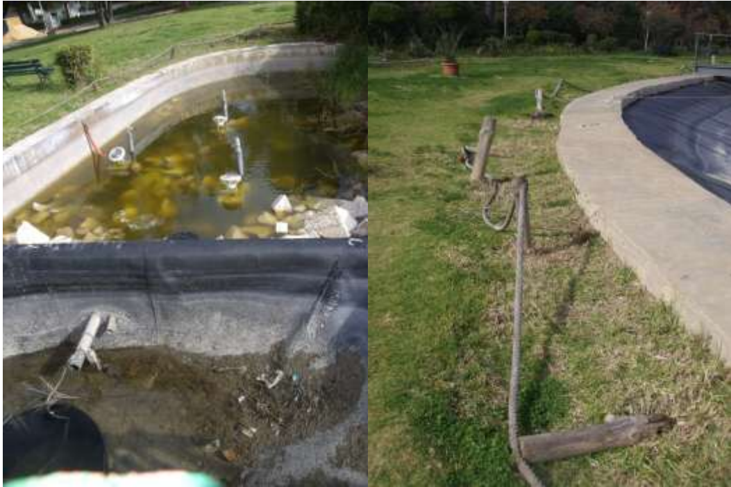
Figure 38 : Au parc de Sidi Bou Saïd : la pièce d’eau du parc non fonctionnelle, l’eau stagnante et sale, les rondins de bois qui assurent la délimitation sont cassés et non réparés. ©B. Loukil, 2012.
