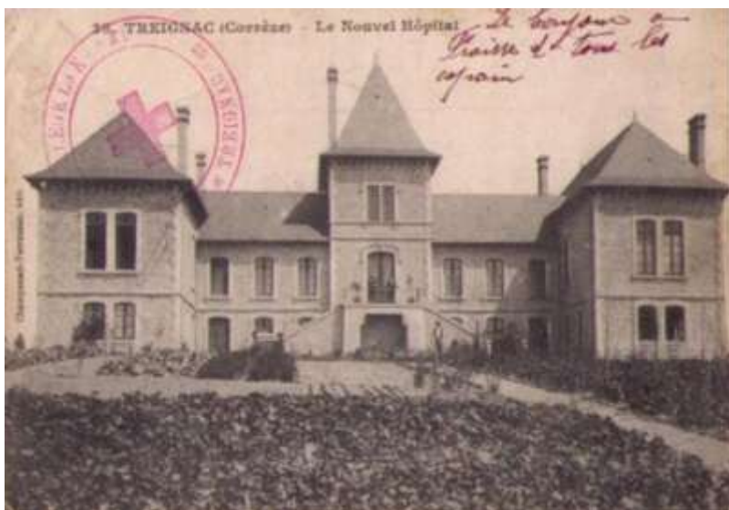
Figure 2: Treignac (Corrèze, France) - Le Nouvel Hôpital (1900), Façade de l'hôpital avec jardin potager) (carte postale de 1915), © mistercard.net
