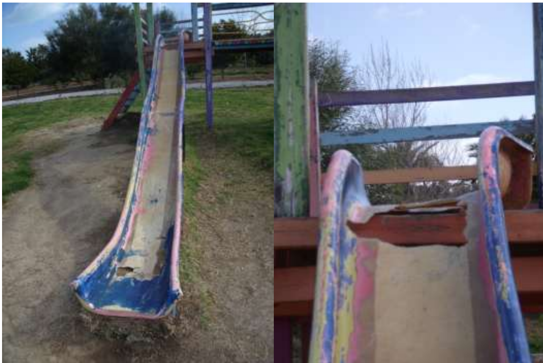
Figure 37 : Au parc de Sidi Bou Saïd : En haut, l'aire de jeux présente un état dégradé, le gazon qui assure la protection des enfants est non renouvelé, les toboggans du parc n'ont jamais atteint cet état de dégradation. ©B. Loukil, 2012.
