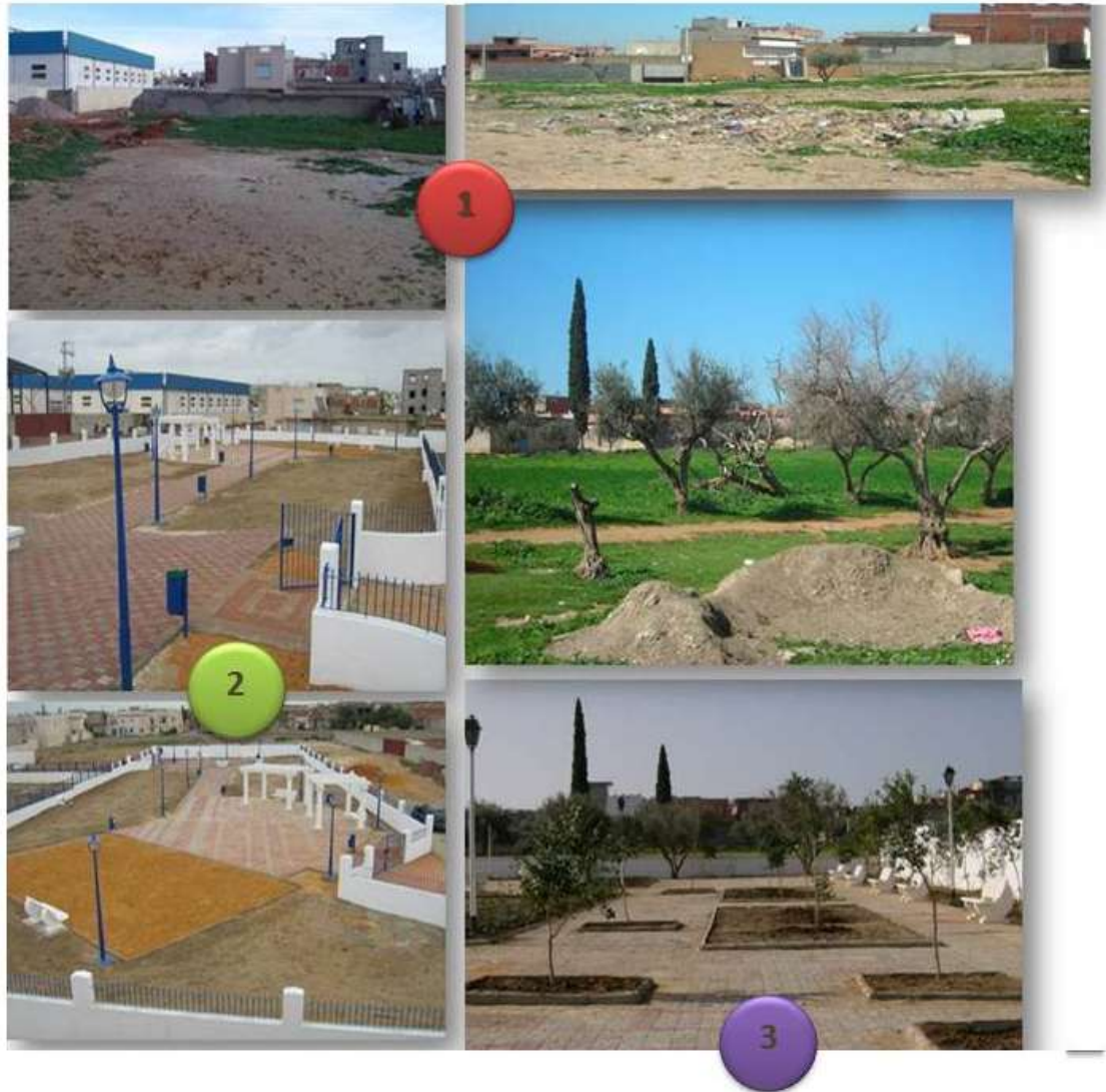
Figure 30 : A gauche : Jardin à la cité Tadhamen (Tadhamen, Ariana), superficie : 1800m 2 , clôture 187m, 2 portes d'entrée, 2 bancs, aire de jeux pour enfants 40m 2 : (1) Site avant l'aménagement, (2) et (3) travaux de génie civil achevés (coût : 96 MD) (2010). A droite le jardin de la cité Jayara à Sidi Hsine (Tunis) (1) et (2) quartier avant aménagement du jardin (3) jardin achevé (2007). ©MEDD, 2010 et 2007.
