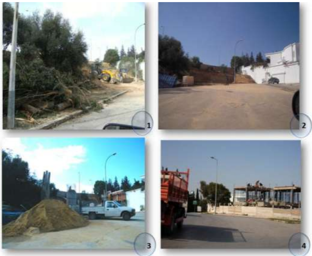
Figure 114 : Evolution d'une construction au Belvédère :(1) « Arrachage d'arbres centenaires effectués le 8 octobre 2010 », (2) « Terrain après arrachage des arbres, le 24 octobre 2010 », (3) « Chantier, 31 janvier 2011 », (4) « Chantier hyper actif, le 24 mars 2011 », ©Emna Charfi.
