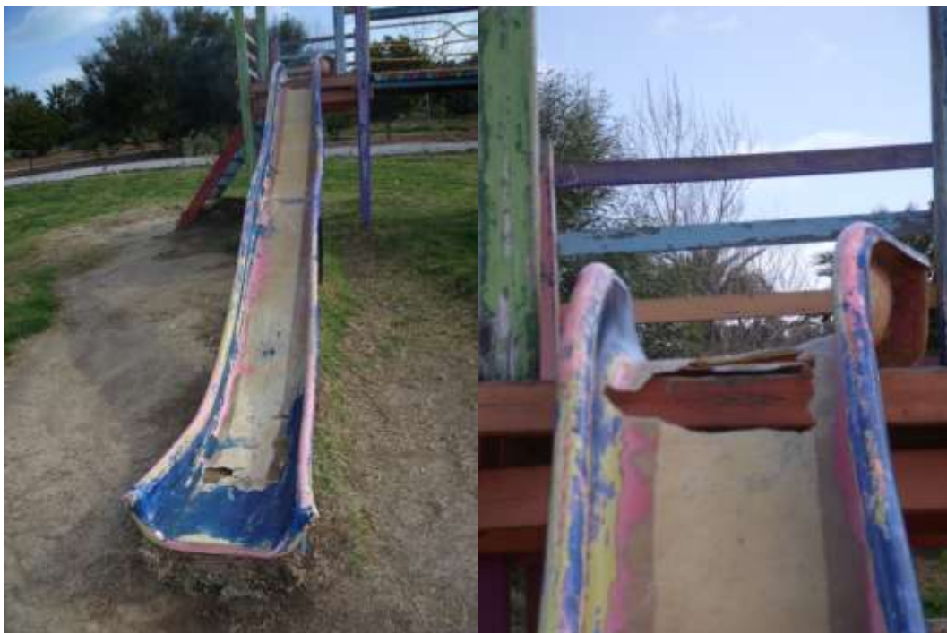
Figure 37 : Au parc de Sidi Bou Saïd : En haut, l'aire de jeux présente un état dégradé, le gazon qui assure la protection des enfants est non renouvelé, les toboggans du parc n'ont jamais atteint cet état de dégradation. ©B. Loukil, 2012.
