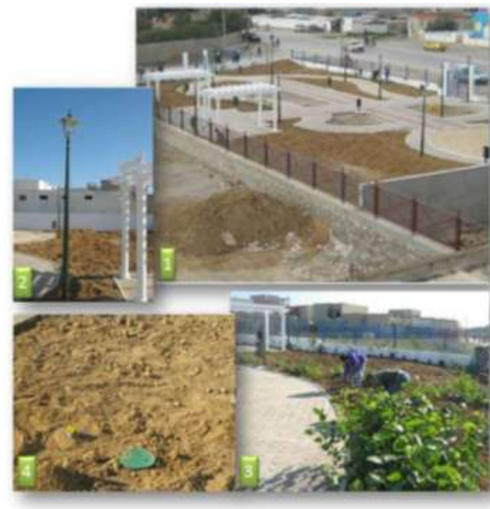
Figure 29 : Projet d'aménagement d'un jardin à Naassan (Gouvernorat de Ben Arous) budget : 150 MD, (1500m 2 , clôture 160m, 2 portes d'entrée, 2 bancs, bac à sable pour enfants (2,5m 2 ), (1) vue d'ensemble de l'espace : (2) éclairage public avec lampes incassables; (3) opération de plantation et (4) réseau d'irrigation automatique. ©MEDD, novembre 2009.
