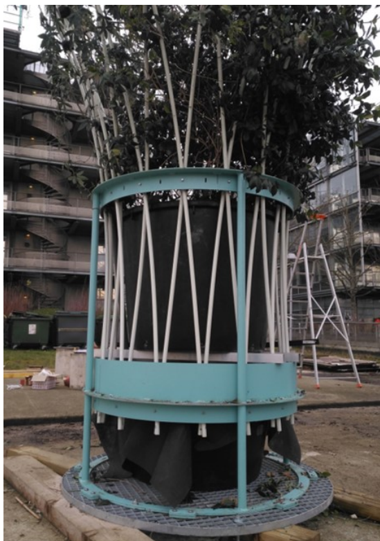
(a) Fixation du gridshell, réserve d'eau et pot contenant le substrat.
