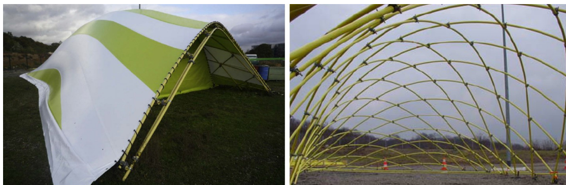
FIGURE 4.16 – Le premier gridshell en matériaux composites à l'ENPC (2006).
