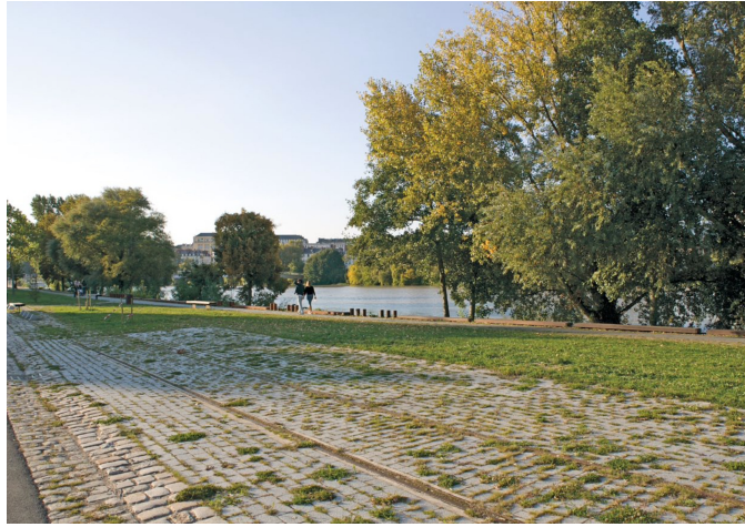
(b) Photographie du Quai François Mitterrand.
