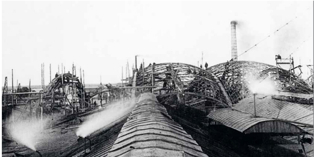
(a) Avant le montage du gridshell (Schusev MA).
