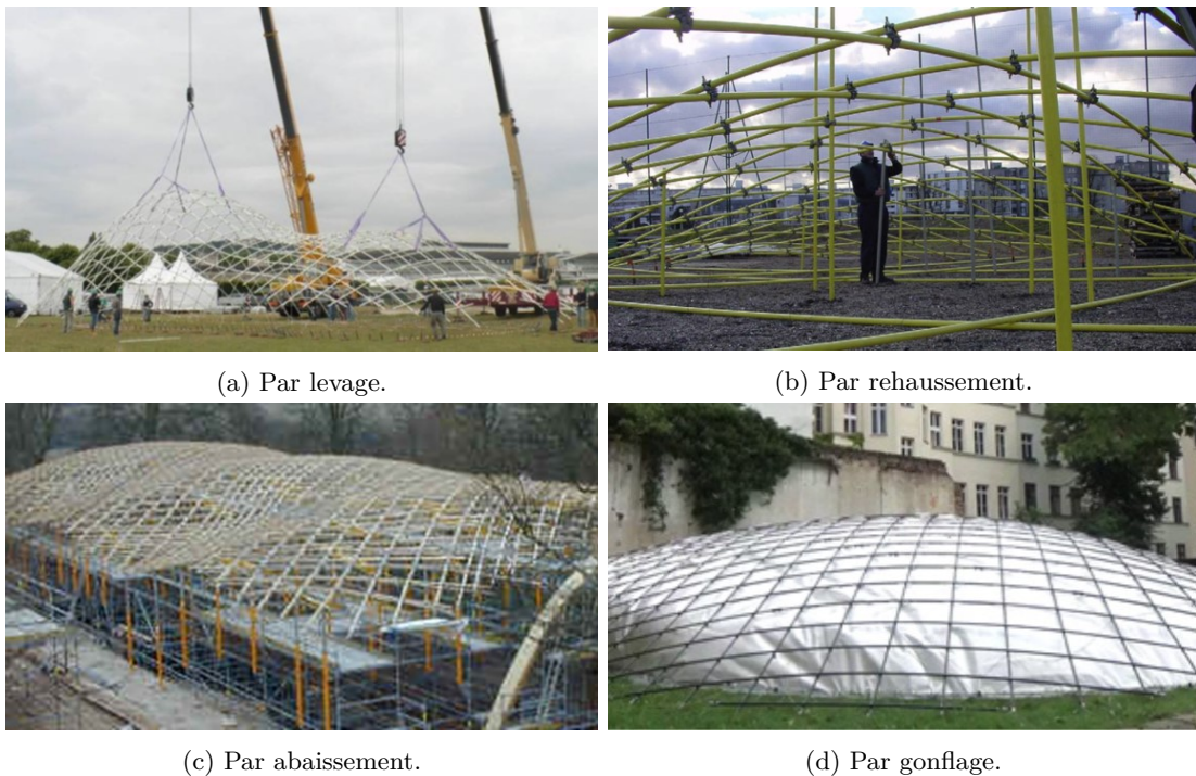
FIGURE 4.24 – Méthodes de montage.
