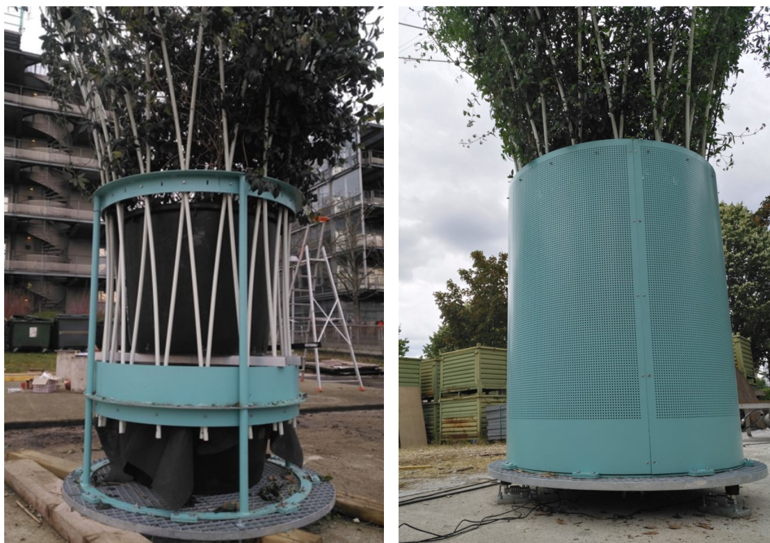
(a) Fixation du gridshell, réserve d'eau et pot contenant le substrat.
