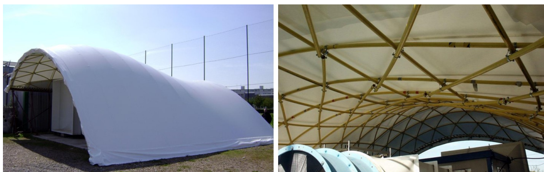
FIGURE 4.17 – Deuxième gridshell à l'ENPC (2007).
