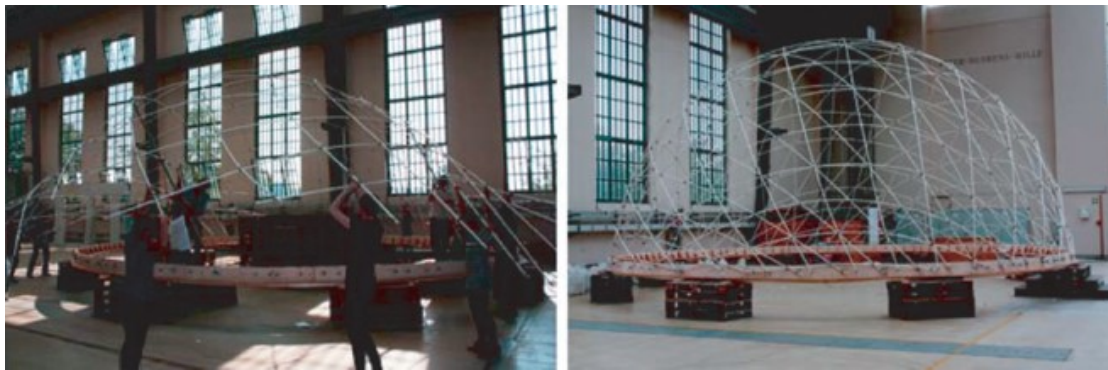
FIGURE 4.20 – Le gridshell hémisphérique Flying Dome (2013). (Image :Hernández et al. (2013))
