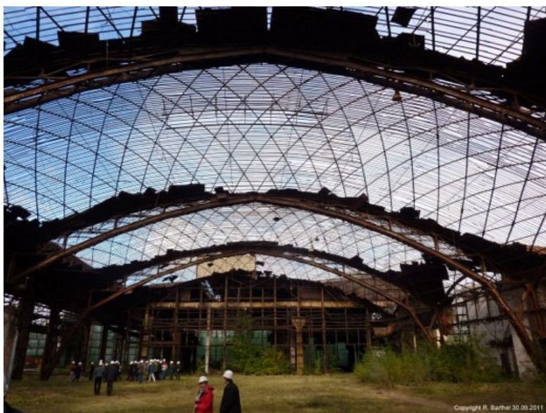
FIGURE 4.5 – L'intérieur de la halle de Vyksa en 2011 (image : Rainer Barthel).
