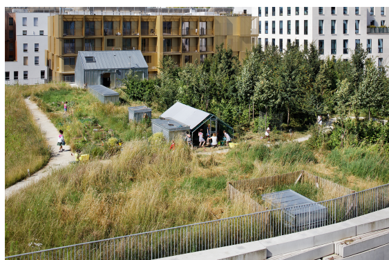
(b) Vue du toit végétalisé.
