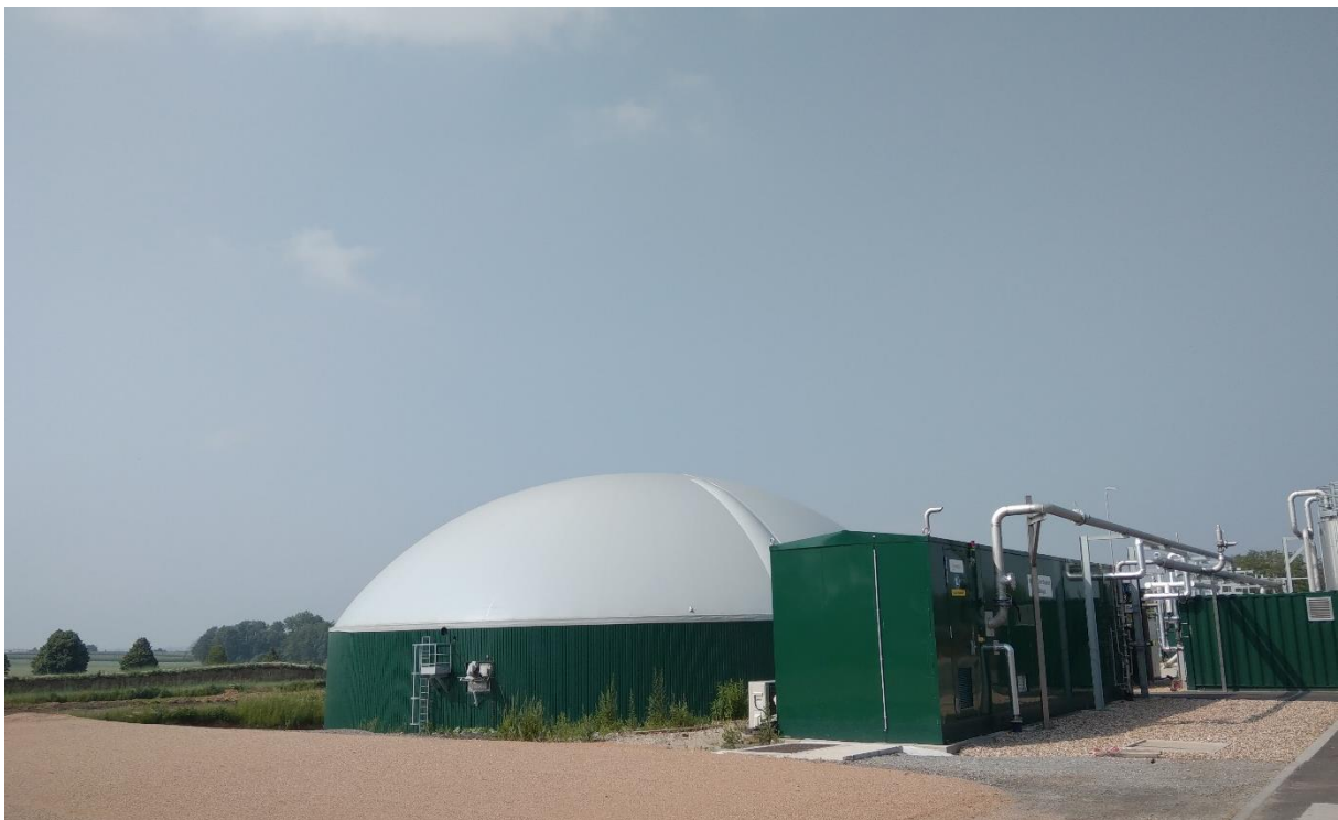
Figure 1 : La méthanisation des matières a lieu dans un digesteur (dôme à gauche), le biogaz produit est épuré dans le cabanon d'épuration (à droite). (Source : autrice).
