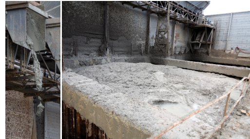
(d) Bac des déblais à la sortie du tunnel
