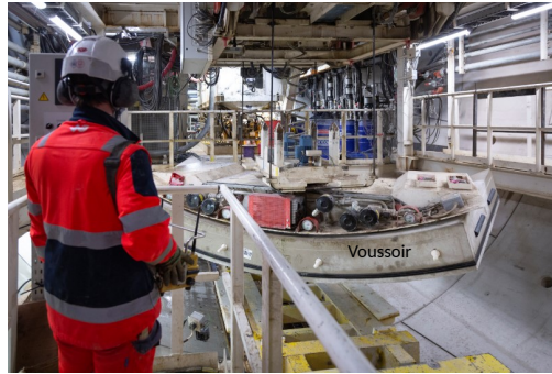
(j) Prise en charge du vousoir à l'intérieur du tunnel
