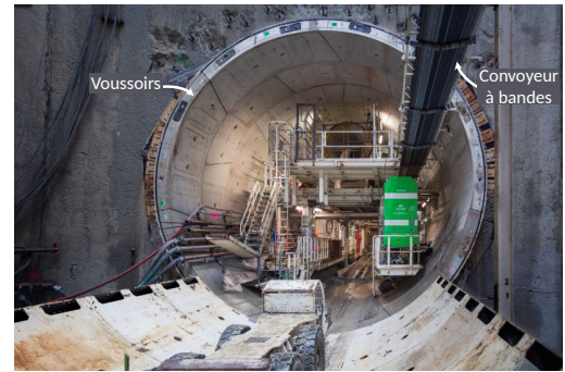
(b) Vue de l'extérieur du tunnel
