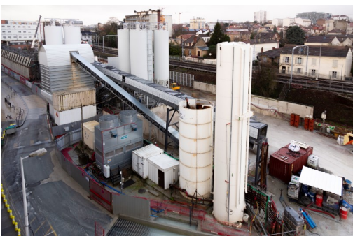
(o) Usine de fabrication de mortier au chantier
