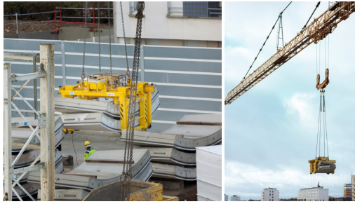
(a) Voussoirs en stock et en cours de transport
