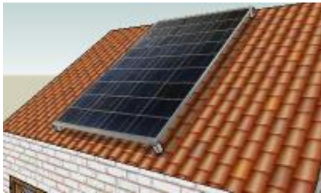
Figure 5.1 : Intégration des panneaux photovoltaïques en toiture
