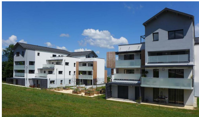
Figure 6.4 : Résidence Les Roches Blanches à Chambéry
