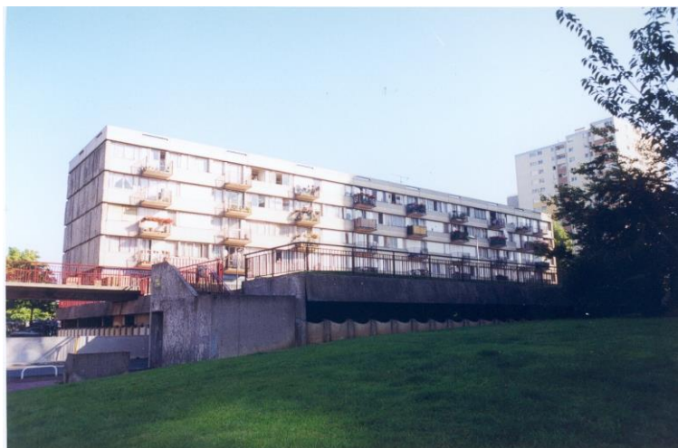
Figure 6.1 : Immeuble HLM à Montreuil
