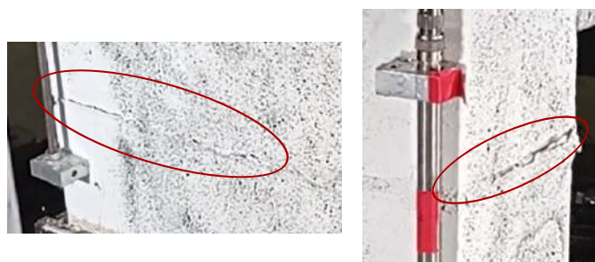
FIGURE 8.20 – Rupture du bord des joints de mortier
