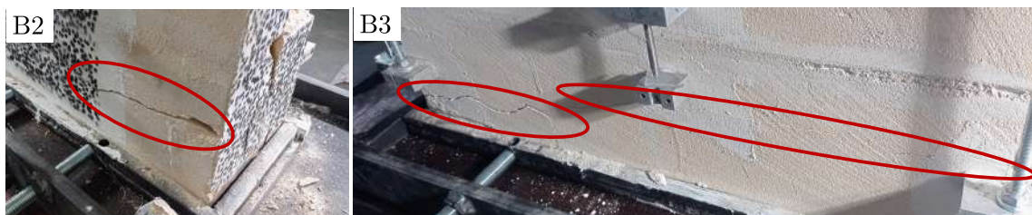
FIGURE 8.29 – Rupture par fissuration de la pierre
