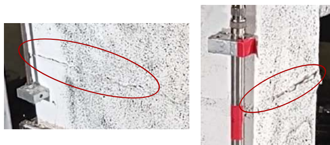
FIGURE 8.20 – Rupture du bord des joints de mortier
