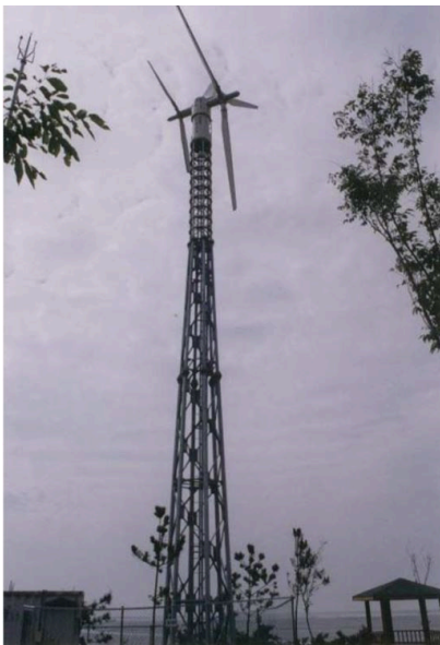
(a) Installation éolienne double rotor en Corée tirée de [21]
