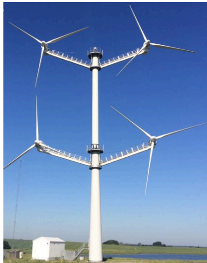
FIGURE 12 – Démonstrateur Vestas multi rotors coplanaires, tiré de [16]
