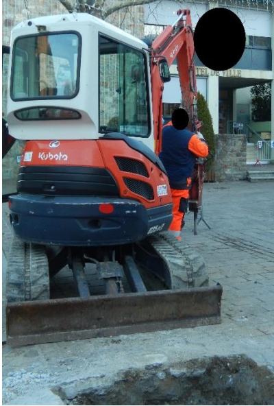
Figure 20. Branchement du BRH sur le bras articulé de la mini-pelle.
