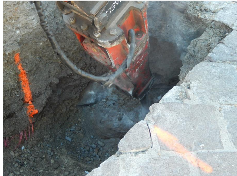
Figure 20. Branchement du BRH sur le bras articulé de la mini-pelle. Figure 21. À l'attaque du caillou.
