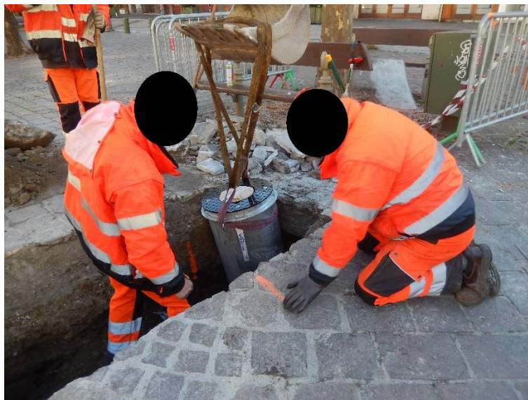
Figure 17. Plus tard dans la matinée, une première tentative de mise en place. Les repères tracés à la bombe orange sur le sol et sur la paroi de la tranchée indiquent l'emplacement souhaité pour la borne.
