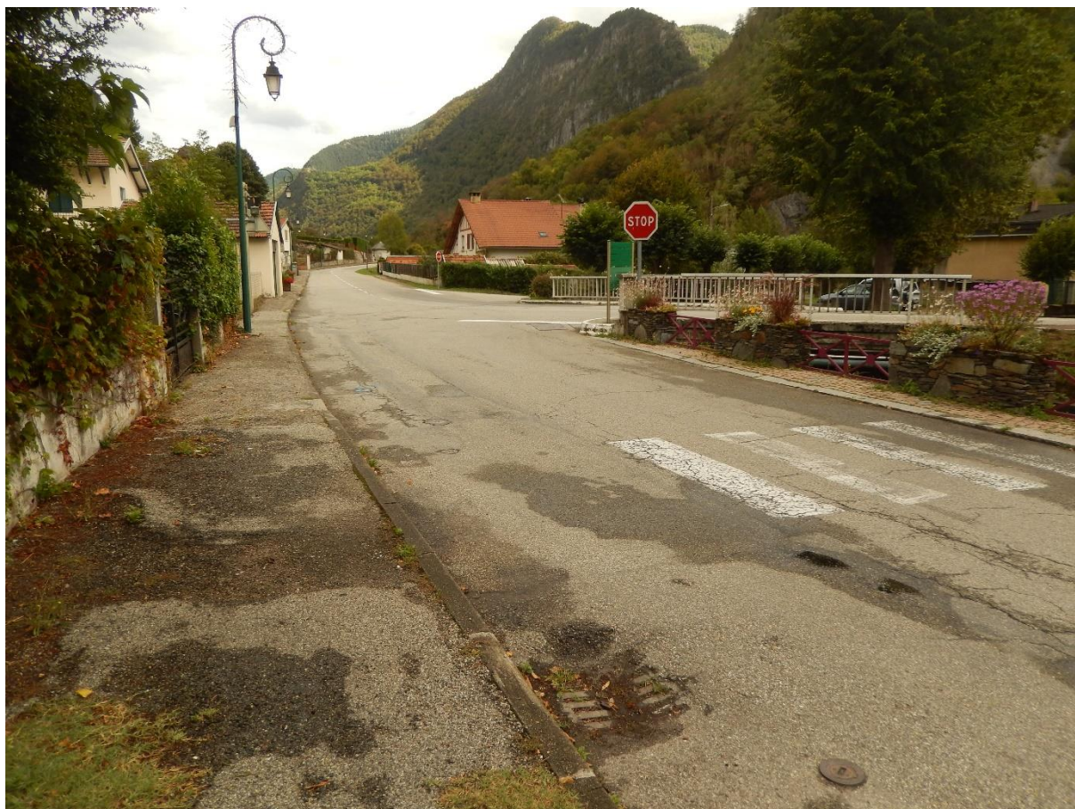
Figure 32. L'extrémité d'un réseau de voirie communale.
