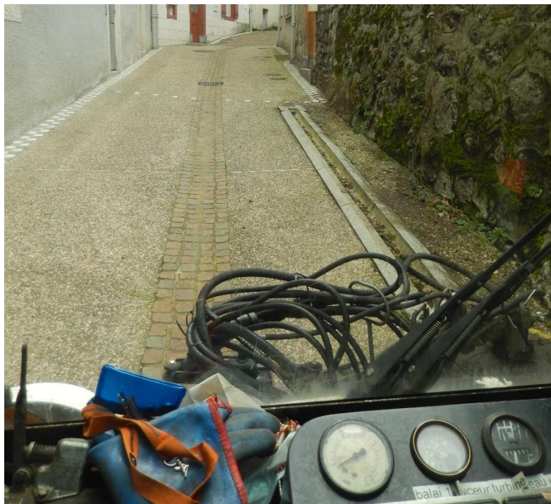
Figure 14. Deux exemples de caniveaux-objets, vus par-dessus le tableau de bord de la balayeuse. Celui de droite n'est pas suffisamment large pour être nettoyé en profondeur par la brosse de la balayeuse, mais sa régularité compense par un meilleur écoulement.
