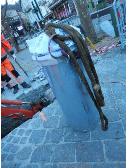
Figure 16. Le caisson d'une borne amovible, en attente d'installation.
