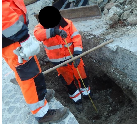
Figure 18. Mesure de la profondeur au milieu de la tranchée. Le manche de la pelle permet de situer le niveau du sol.
