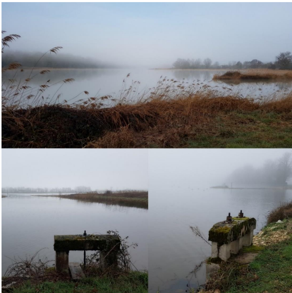
Figure 17 : Exemples d'étangs piscicoles dombistes et de leur système de vidange (le thou).
