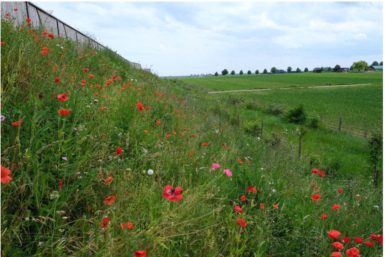
Illustration 15 : Talus végétalisé, Contournement Ouest de Strasbourg, kilomètre 3 – Crédits: Anaël Mayeur
